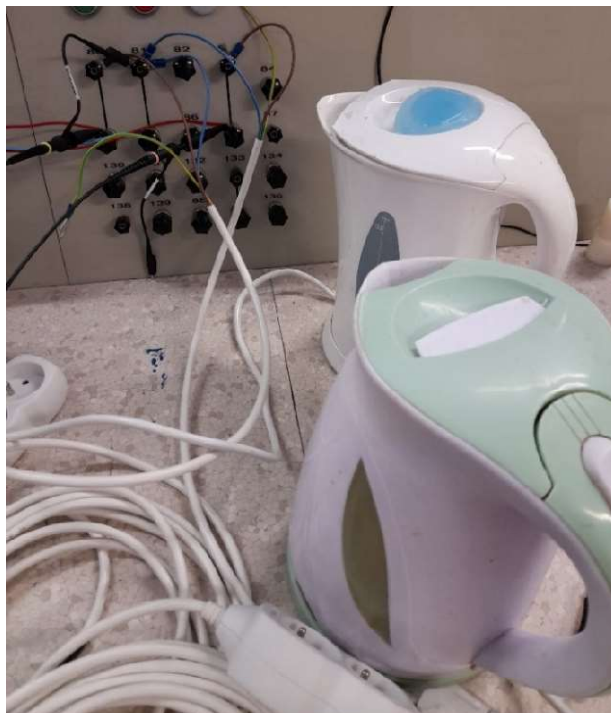
Obrázek č. 12 – Odporová zátěž Scottova transformátoru
