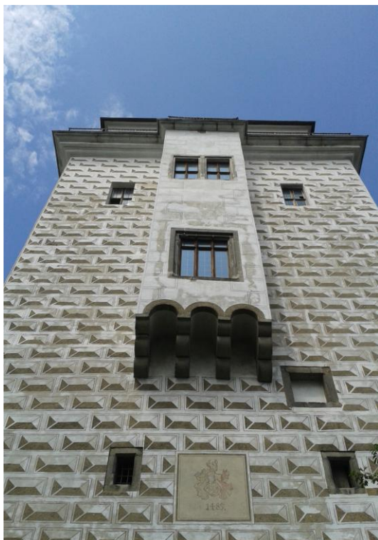
Obr. č. 28: Věž zámku (zdroj: vlastní, 14. 4. 2013)
