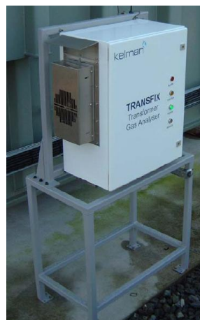
Obr. 6: Umístění multi-gas senzoru Transfix – převzato z [21]
