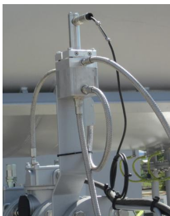
Obr. 7: Buchholz relé senzor
