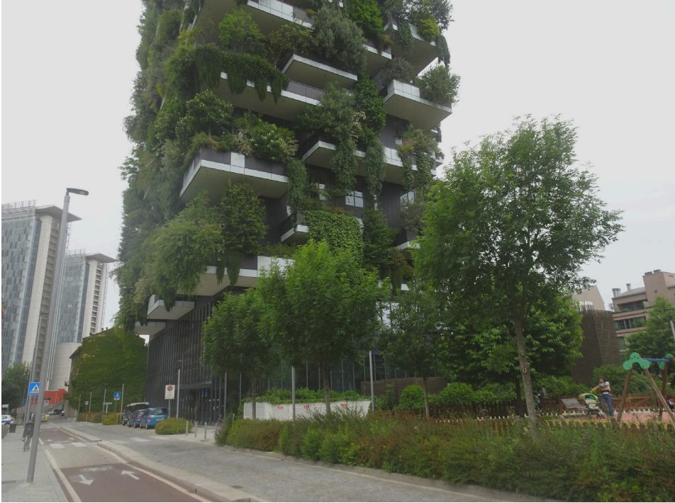
Obr. 1.2 Milánská budova Bosco Verticale (vertikální les) je příkladem projevů ekologického urbanismu v architektuře. Zdroj: foto autoři
