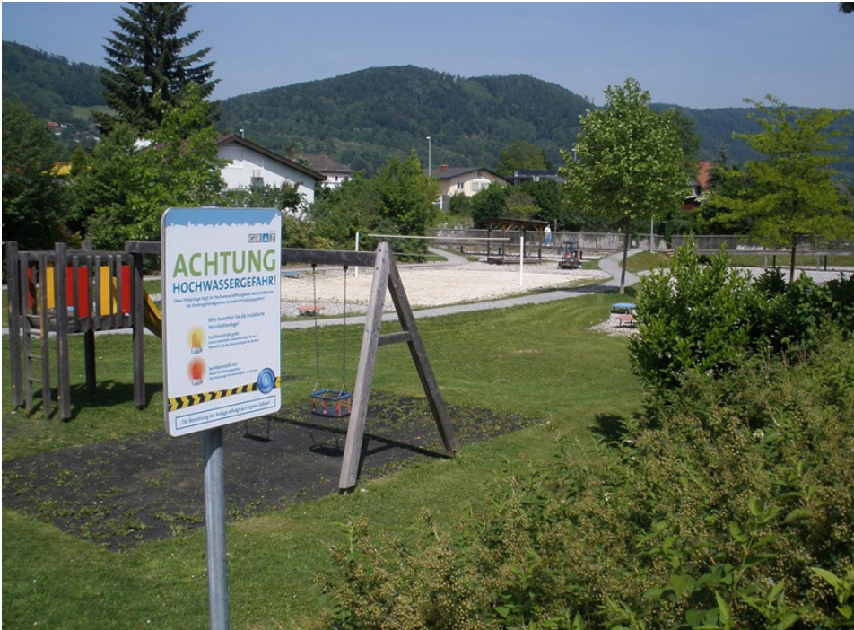
Obr. 1.3 Smart prvky hospodaření s dešťovou vodou ve městě: součástí povodňového parku je varovný systém se světlenou signalizací napojený na monitoring výšky srážek a hladiny vody v parku (Graz, Schererpark). Zdroj: foto autoři
