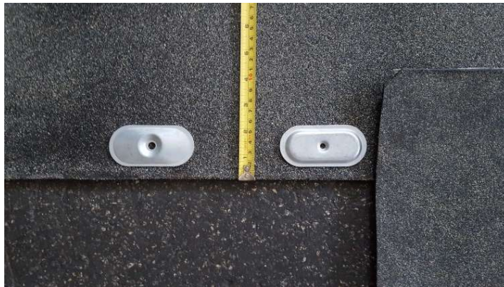
Obrázek 7 - kotvení asfaltového pásu [14]
