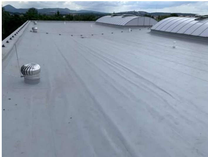
Obrázek 1- Hydroizolace střechy halového objektu [1]
