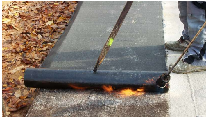
Obrázek 5 - Natavování asfaltového pásu [11]
