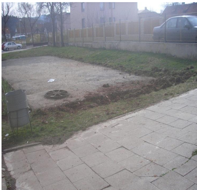
Obrázek 20 Betonové plato proti vchodu do šaten
