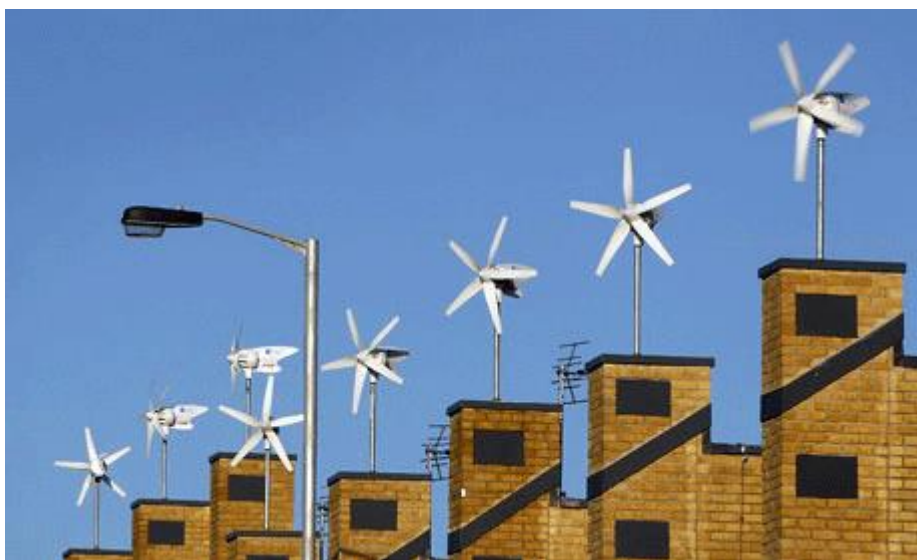
Obr. 2.11.: Mikro větrné elektrárny na rodinných domech ve Velké Británii [5]
