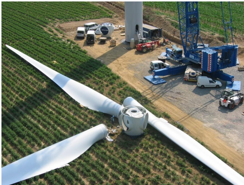
Obr. 4.1.: Stavba větrné elektrárny Janov [14]
