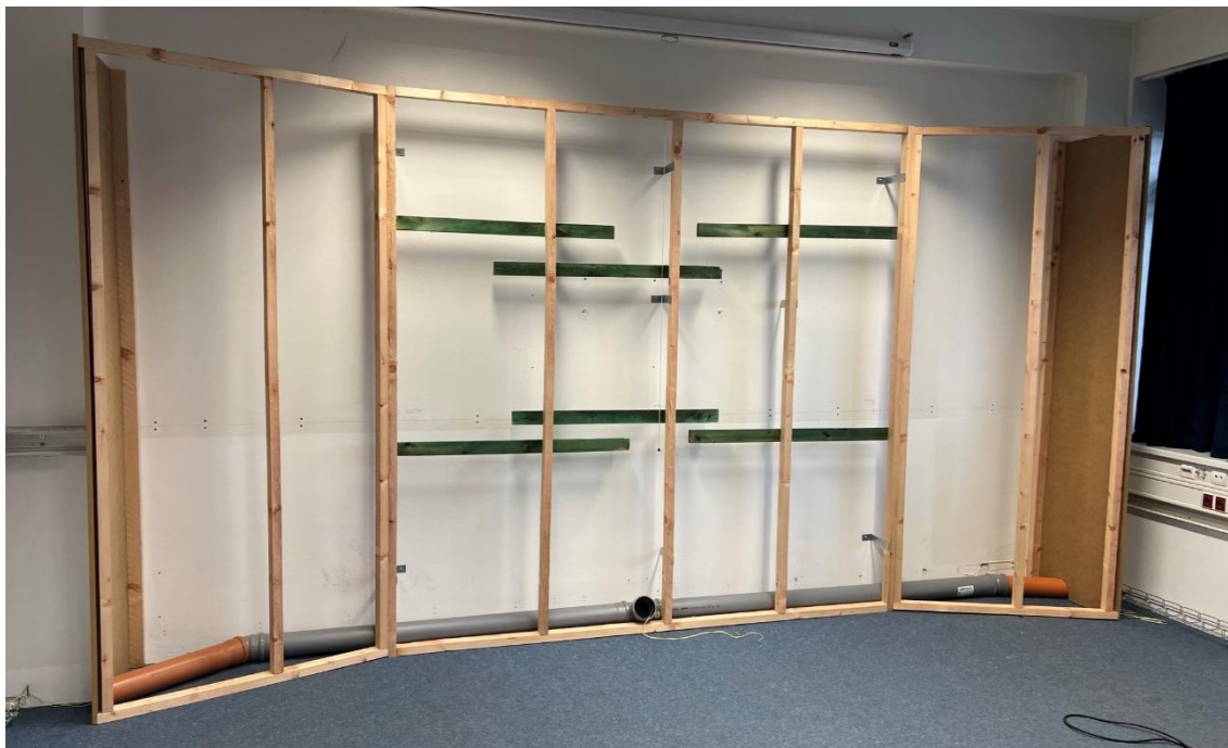
Obrázek 5-7: Foto dřevěné konstrukce rezonátoru.
