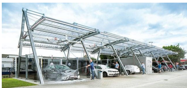
Obr. 5 - Samoobslužné mytí Skywing, [3]
