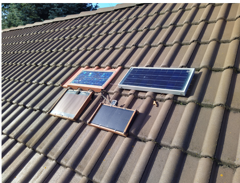
Obrázek 3.2: Detail modelové instalace
