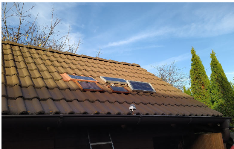
Obrázek 3.9: Zastínění spodních dvou panelů střechou rodinného domu
