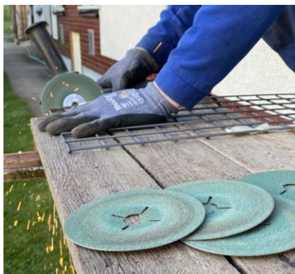
Obrázek č. 32 – úprava úhlovou bruskou (archiv autora)
