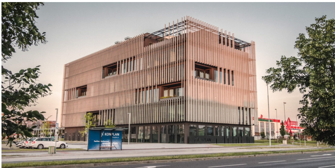
Obr. č. 7: Budova Konplan
