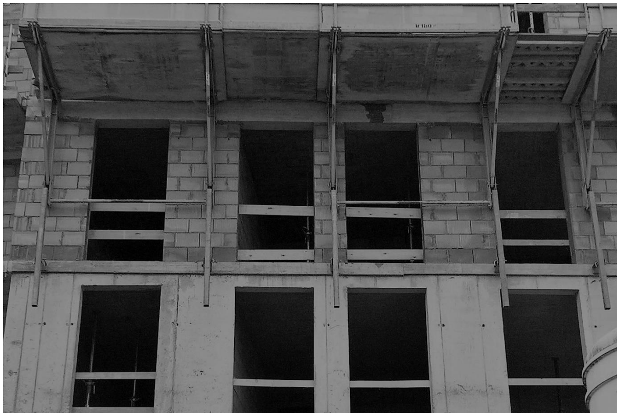
Obr.37 – Ukázka maltovaných styčných spár mezi cihlami u pilířů, spojují pilíř a zajišťují jeho jednodolitost
