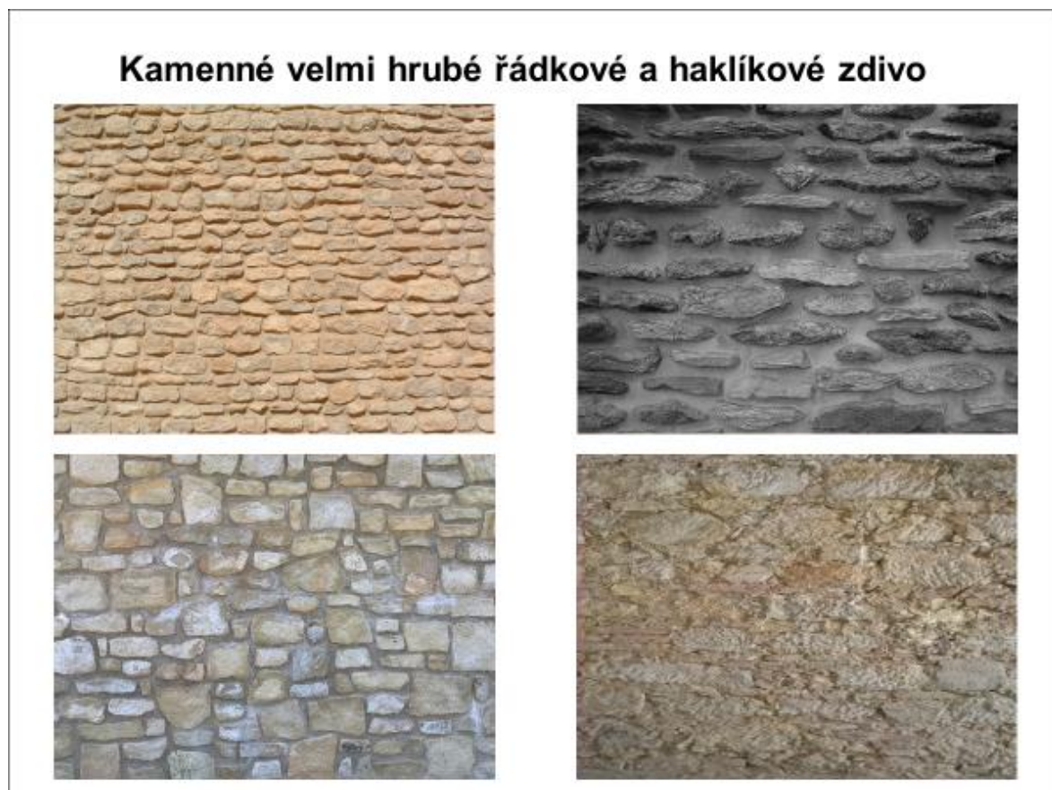
Obr.12 – Hrubé řádkové zdivo až z plochých kamenů
