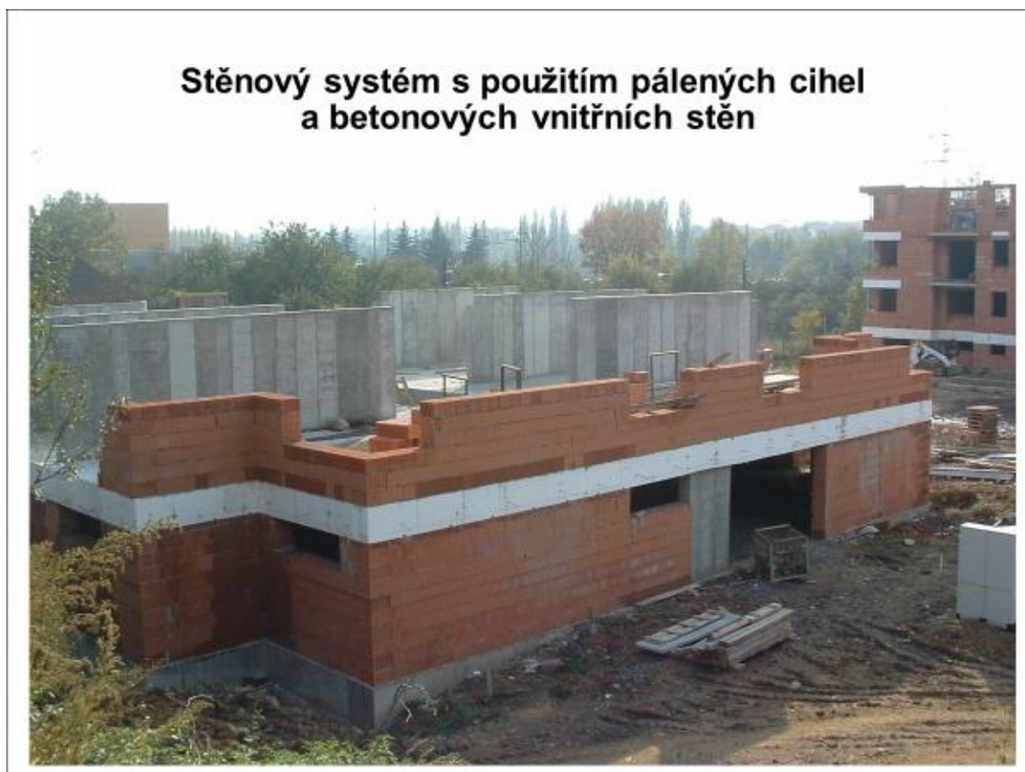
Obr.21- Ukázka stěnového systému
