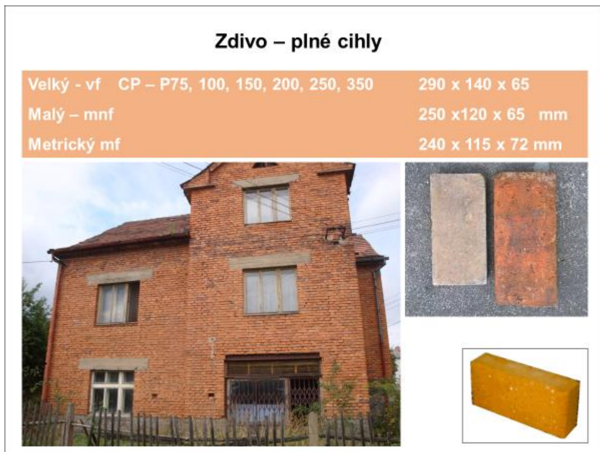
Obr.9 – Ukázka zdiva z plných cihel velkého, malého a metrického formátu
