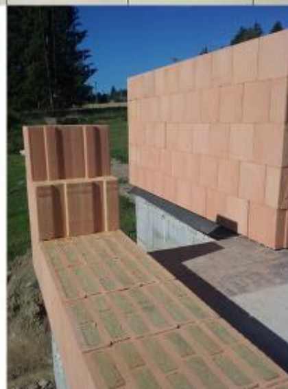
Obr.5 – Ukázky zdiva z pálených cihel – děrovaných bloků a bloků s vnitřní tepelnou izolací
