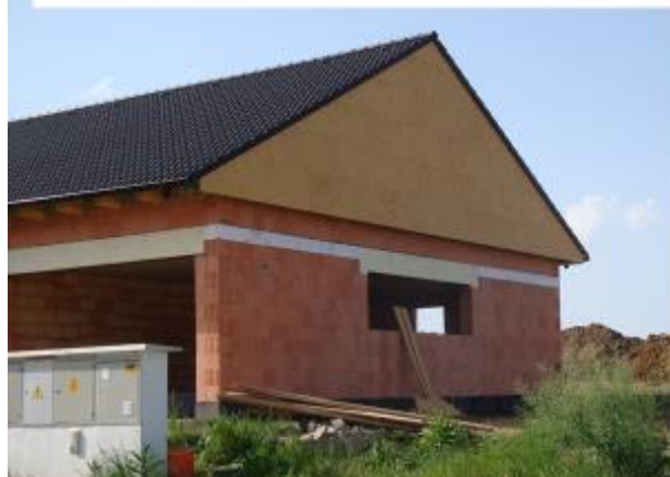
Obr.5 – Ukázky zdiva z pálených cihel – děrovaných bloků a bloků s vnitřní tepelnou izolací
