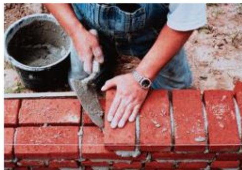
Střídání vazákové a běhounové vazby
