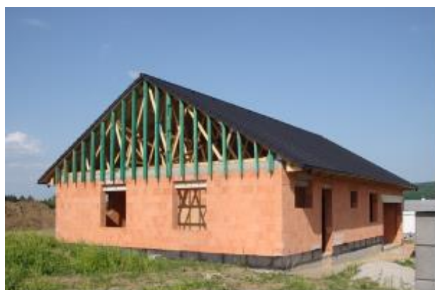
Stěnový systém z pálených voštinových cihel a se střechou z příhradových dřev. nosníků
