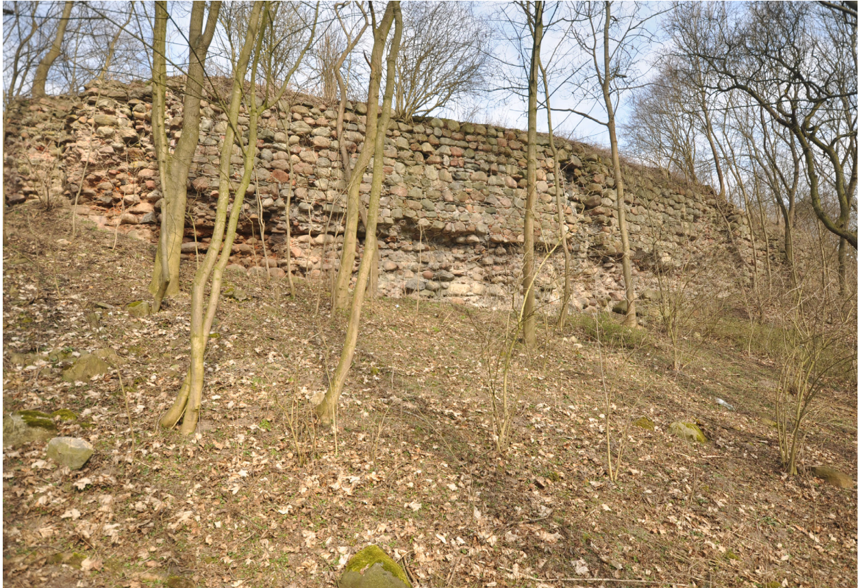
Obr. 3. Mur parchamu zamku w Lipienku – widok od południa. Fot. B. Wasik. – Abb. 3. Zwingermauer der Burg in Lipienek – Sicht von Süden. Foto B. Wasik.
