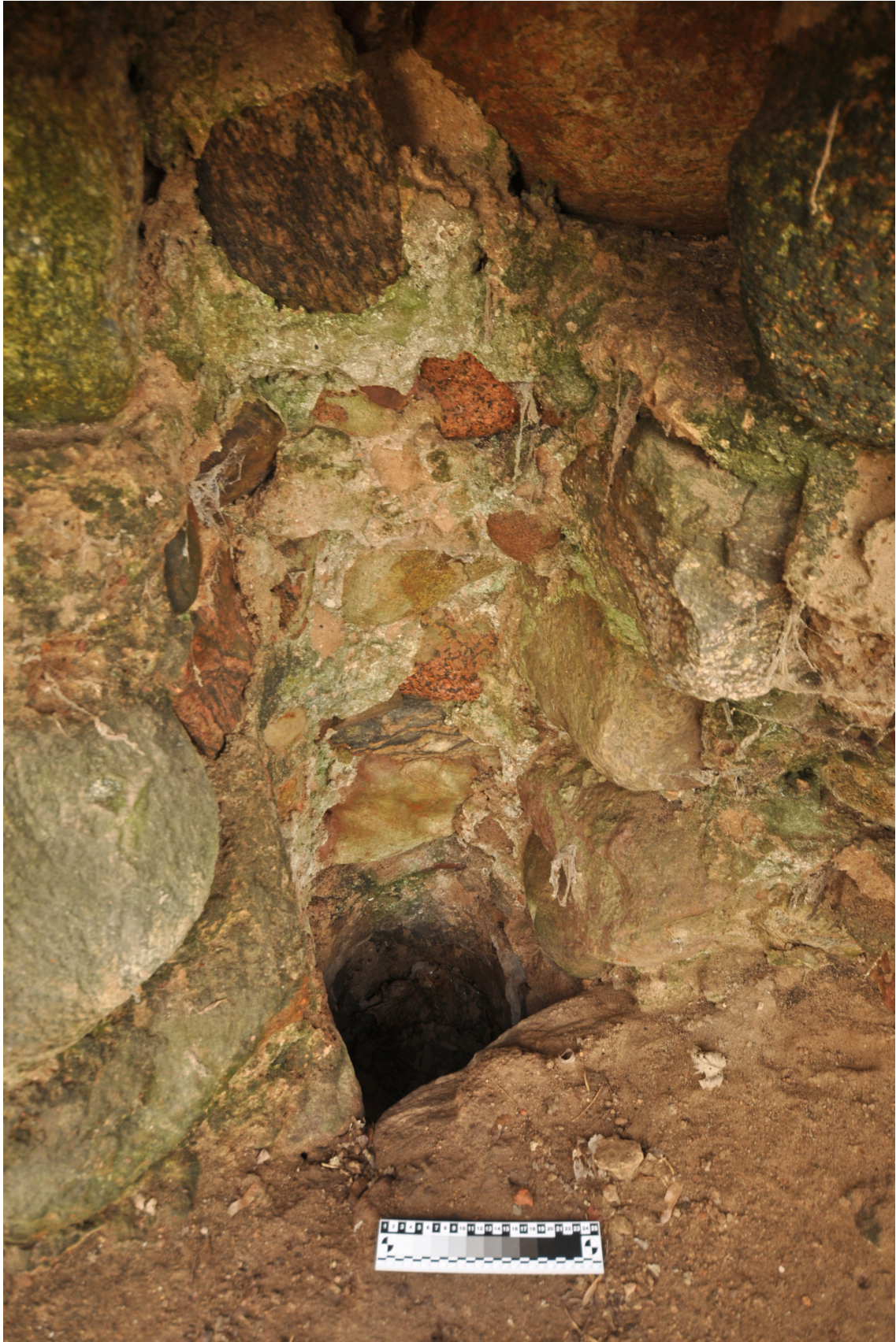
Obr. 11. Negatyw słupa w rdzeniu muru parchamu. Fot. B. Wasik. – Abb. 11. Negativ nach einem Pfeiler in der Zwingermauer. Foto B. Wasik.
