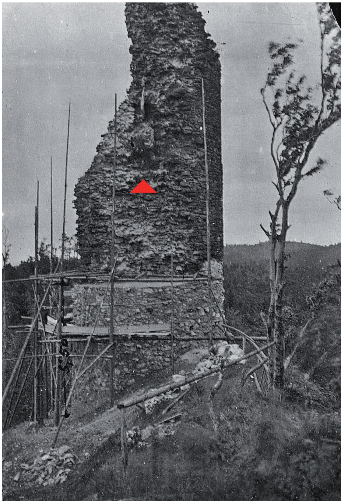
Obr. 5. Hrad Reichenstein (okr. Schwandorf). Stavební zajištění a stabilizace pláště bergfritu v letech 1926–1929. Na snímku zachycen původní vstup (Archiv spolku Heimatkundlicher Arbeitskreis Stadlern). – Abb. 5. Die Burg Reichenstein (Bez. Schwandorf). Bausicherung und Stabilisierung des Bergfriedsmantels in den Jahren 1926–1929. Sichtbar ist der ursprüngliche Eingang (Archiv des Heimatkundlichen Arbeitskreises Stadlern).
