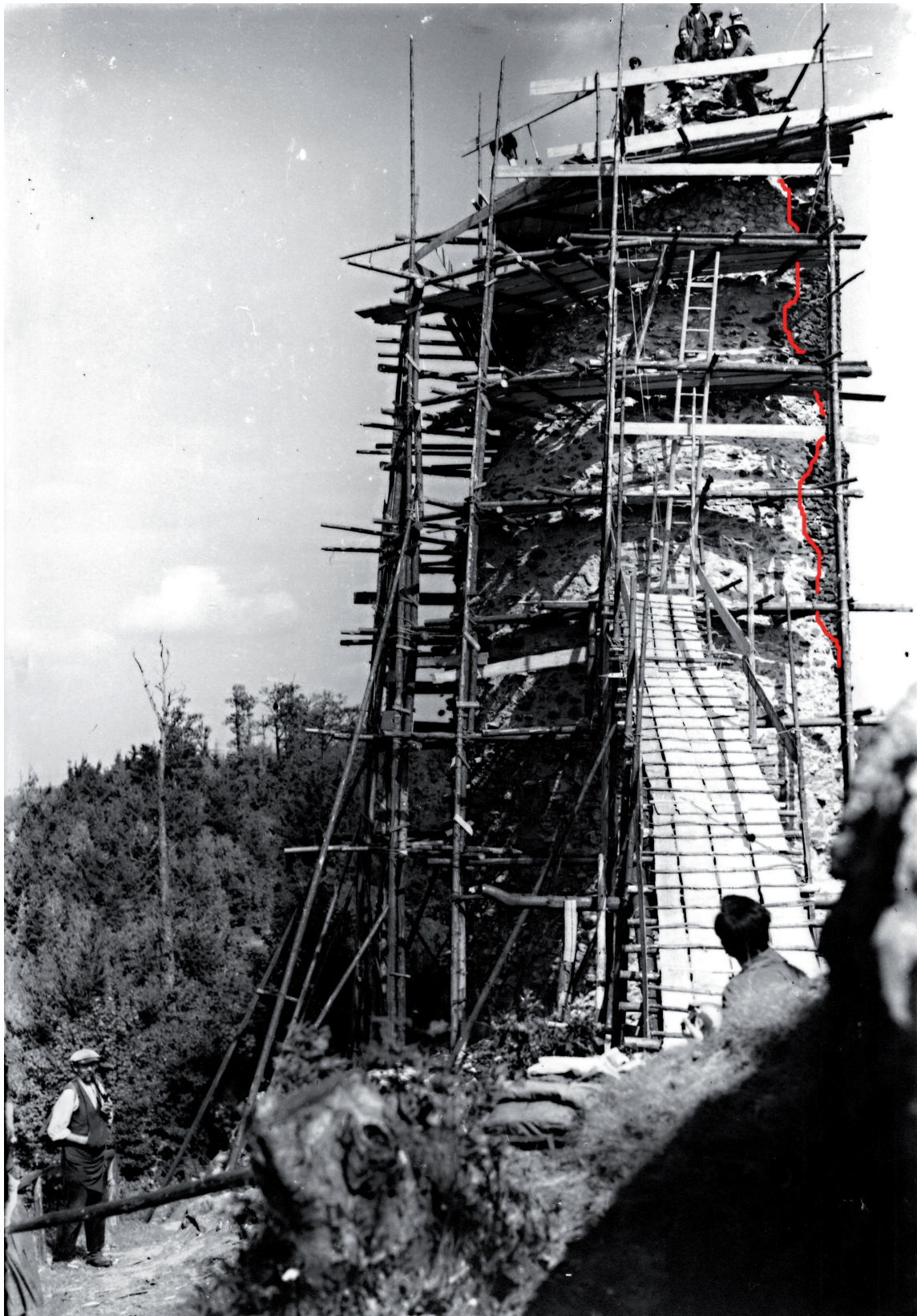
Obr. 7. Hrad Reichenstein (okr. Schwandorf). Stavební zajištění a stabilizace bergfritu v letech 1926–1929. Snímek zachycující dokončovací práce (Archiv spolku Heimatkundlicher Arbeitskreis Stadlern). – Abb. 7. Die Burg Reichenstein (Bez. Schwandorf). Bausicherung und Stabilisierung des Bergfriedsmantels in den Jahren 1926–1929. Beendigungsarbeiten (Archiv des Heimatkundlichen Arbeitskreises Stadlern).
