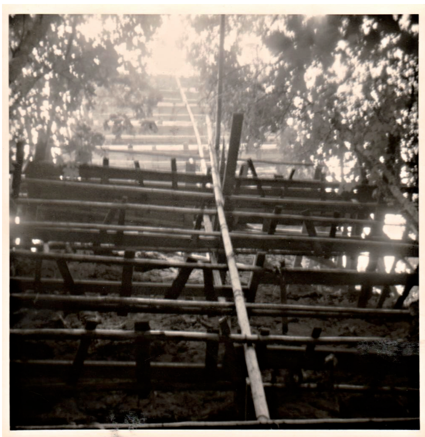
Obr. 10. Hrad Reichenstein (okr. Schwandorf). Stavební zajištění a stabilizace bergfritu v letech 1962–1963. Snímek zachycující lešení na východní straně (Archiv spolku Heimatkundlicher Arbeitskreis Stadlern). – Abb. 10. Die Burg Reichenstein (Bez. Schwandorf). Bausicherung und Stabilisierung des Bergfriedsmantels in den Jahren 1962–1963. Baugerüst auf der Ostseite (Archiv des Heimatkundlichen Arbeitskreises Stadlern).
