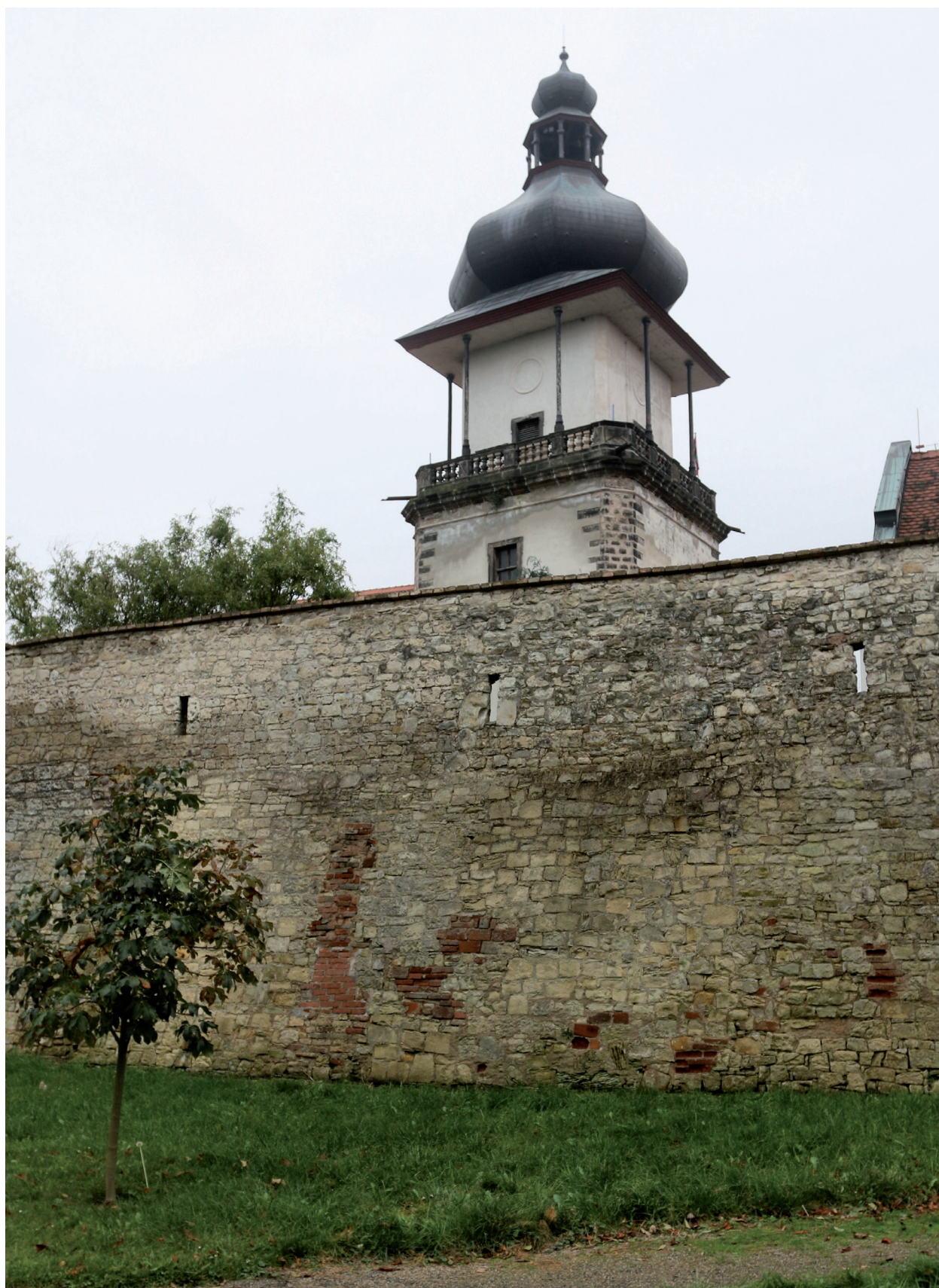
Obr. 5. Nový Hrad u Jimlína. Vnější čelní hradba valu, pohled od severu. Foto autor 2014. – Abb. 5. Nový Hrad bei Jimlín. Äußere Stirnseite der Wallmauer, Blick aus nördlicher Richtung. Foto Autor 2014.
