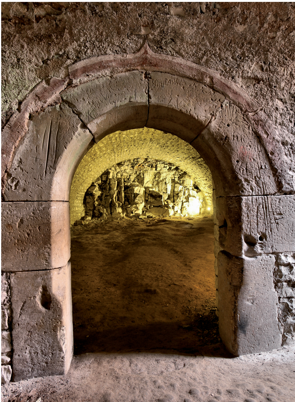
Obr. 11. Nový Hrad u Jimlína. Portál vedoucí do západního sklepa pod Vysokým stavením. Foto autor 2016. – Abb. 11. Nový Hrad bei Jimlín. In den westlichen Keller unter dem „Hohen Bau“ führendes Portal. Foto Autor 2016.
