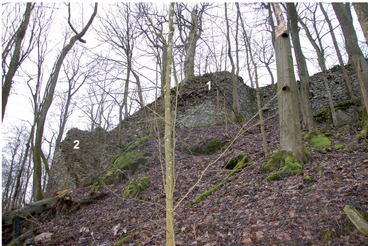
Obr. 10. Nový Herštejn. Východní část hradu nad přístupovou cestou s reliktem původní podkovovité bašty (1) a reliktem objektu s tzv. Panenskou baštou (2). Foto a úprava P. Kastl. – Abb. 10. Nový Herštejn. Ostteil der Burg über dem Zugangsweg mit Resten einer ursprünglich hufeisenförmigen Bastei (1) und Relikten des Objekts mit der sogenannten Jungfernbastei (2). Foto und Bearbeitung P. Kastl.
