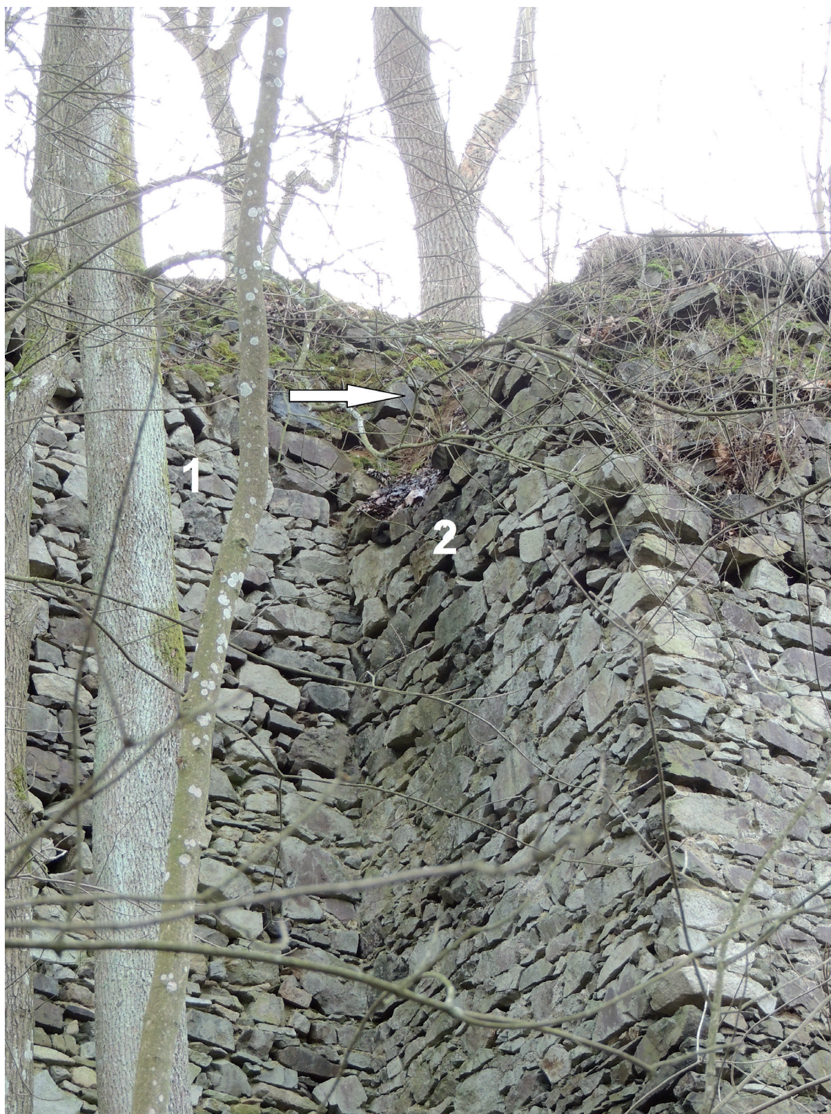
Obr. 2. Nový Herštejn. Detail napojení posledního pozůstatku obvodové zdi jádra hradu (2) na severozápadní nároží donjonu (1). Pod destrukcí koruny zdiva hradby přiložené k donjonu je viditelný probíhající vnější líc donjonu (označeno šipkou). Foto a úprava P. Kastl. – Abb. 2. Nový Herštejn. Detail der Anbindung der letzten Reste der Ringmauer (2) der Kernburg an die nordwestliche Ecke des Donjons (1). Oben den Schutt der Mauerkrone der an den Donjon anschließenden Mauer ist der Verlauf des äußeren Blindmauerwerks (mit Pfeil markiert) der Außenmauern des Donjons sichtbar. Foto und Bearbeitung P. Kastl.
