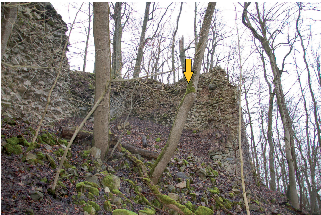
Obr. 9. Nový Herštejn. Část objektu s tzv. Panenskou baštou (označená šipkou) v místě, kde předstupuje před východní obvodovou hradbu. Foto a úprava P. Kastl. – Abb. 9. Nový Herštejn. Teil des Objekts mit der sogenannten Jungfernbastei (mit Pfeil markiert) dort, wo es aus der östlichen Ringmauer hervortritt. Foto und Bearbeitung P. Kastl.
