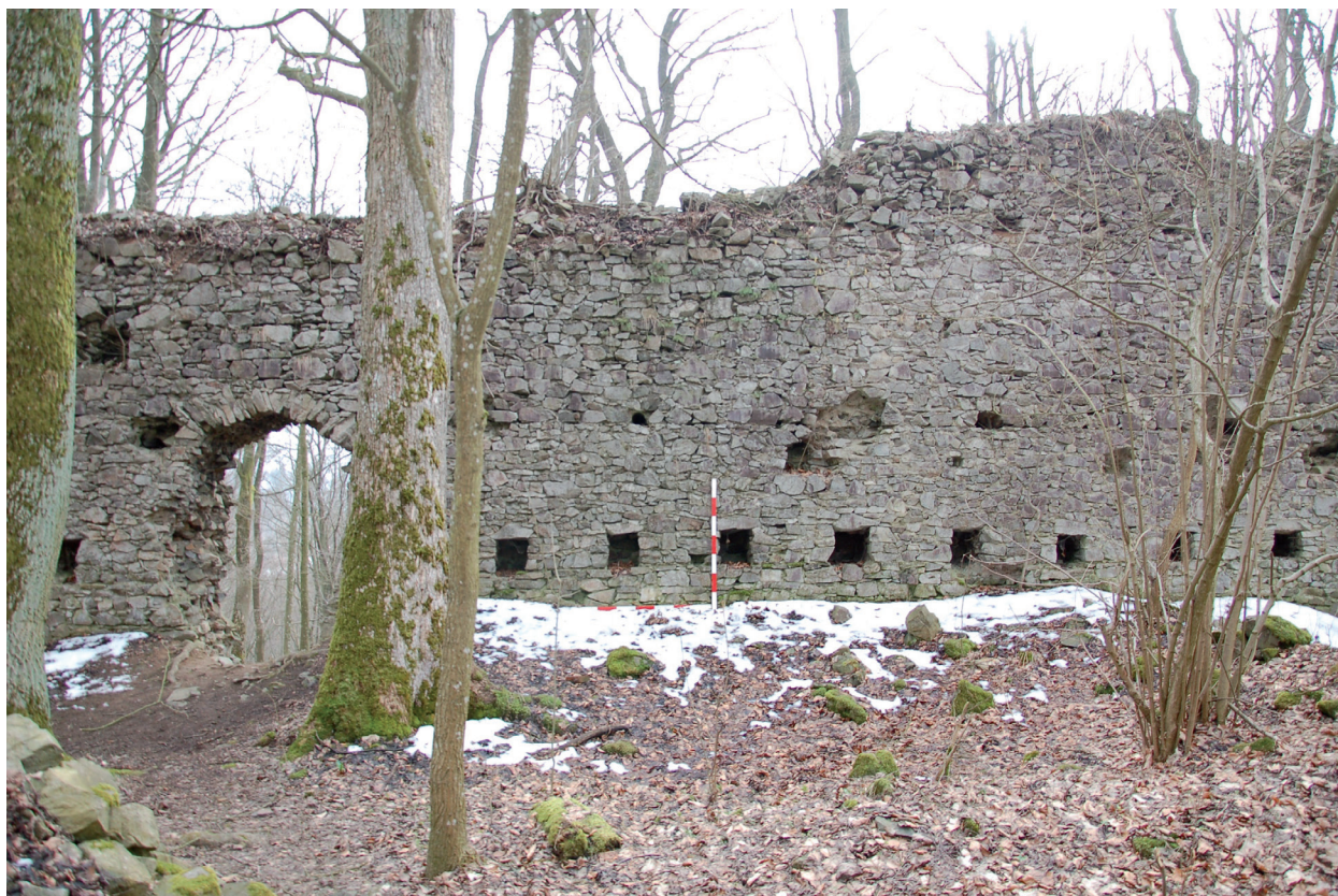
Obr. 13. Nový Herštejn. Tzv. výpádová branka v jihozápadní obvodové hradbě. Pohled na nádvoří stranu. Lať 1,4 m. Foto a úprava P. Kastl. – Abb. 13. Nový Herštejn. Sogenannte Fluchtpforte in der südwestlichen Ringmauer. Blick in Richtung Hofseite. Latte 1,4 m. Foto und Bearbeitung P. Kastl.
