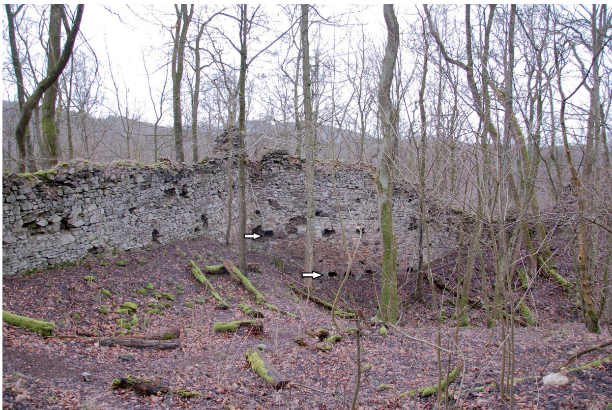
Obr. 7. Nový Herštejn. Dvě řady otvorů (označených šipkou) po stropních trámech patrové budovy přiložené k vnitřnímu líci jihovýchodní části obvodové hradby. Foto a úprava P. Kastl. – Abb. 7. Nový Herštejn. Zwei Lochreihen (mit Pfeil markiert) für die Deckenbalken des mehrstöckigen, an der Innenseite des südöstlichen Teils der Ringmauer errichteten Gebäudes. Foto und Bearbeitung P. Kastl.
