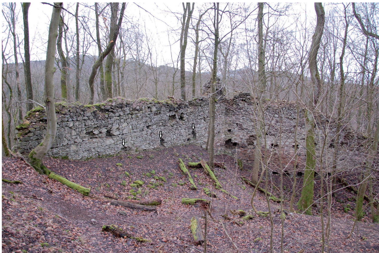
Obr. 8. Nový Herštejn. Vnitřní líc východního úseku obvodové hradby s řadou otvorů (označených šipkami) pro osazení stropních trámů budovy, která nebyla nikdy vystavěna. Foto a úprava P. Kastl. – Abb. 8. Nový Herštejn. Inneres Blendmauerwerk des westlichen Abschnitts der Ringmauer mit einer Reihe Deckenbalkenlöcher (mit Pfeil markiert) für ein Gebäude, welches nie erbaut wurde. Foto und Bearbeitung P. Kastl.
