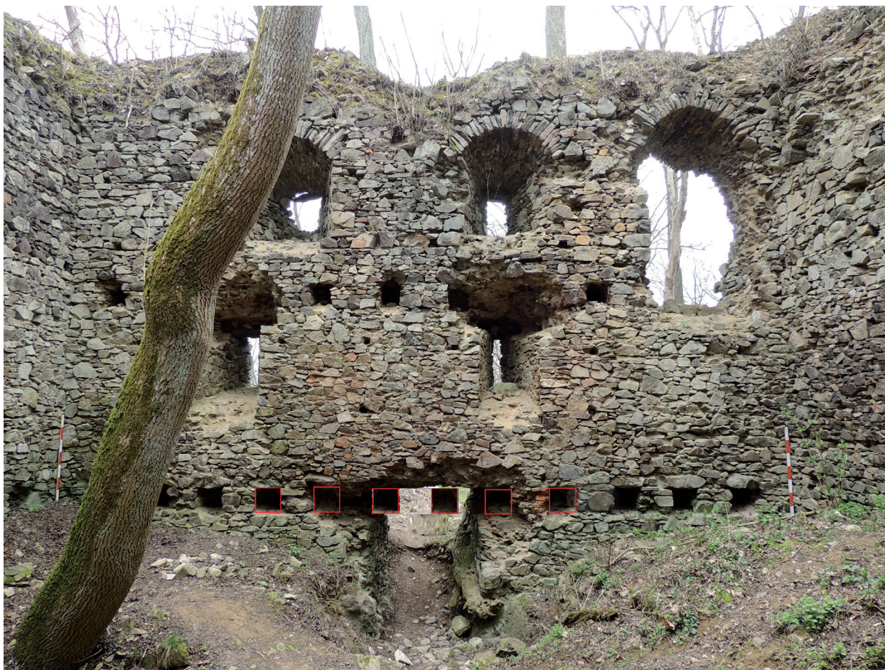
Obr. 4. Nový Herštejn. Předpokládané osazení stropních trámů mezi prvním a druhým podlažím západní stěny donjonu v prostoru nad stavebním otvorem (vchodem?) do prvního podlaží donjonu. Lať 1,4 m. Foto a úprava P. Kastl. – Abb. 4. Nový Herštejn. Mutmaßliche Verteilung der Deckenbalken zwischen dem Erdgeschoss und dem ersten Stock an der Westwand des Donjons über einer Gebäudeöffnung (einem Eingang?) im Erdgeschoss des Donjons. Latte 1,4 m. Foto und Bearbeitung P. Kastl.
