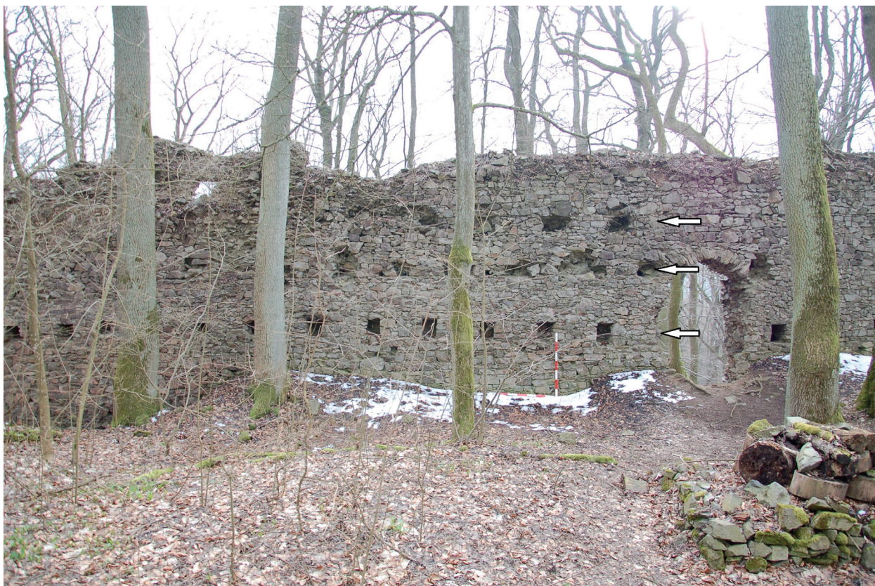
Obr. 14. Nový Herštejn. Tři řady otvorů v jihozápadní obvodové hradbě. Spodní řada pochází z období výstavby obvodové hradby (pol. 14. stol.). Další dvě řady otvorů byly do hradby vylámaný dodatečně pravděpodobně koncem 15. nebo počátkem 16. stol. Latě 1,4 m. Foto a úprava P. Kastl. – Abb. 14. Nový Herštejn. Drei Lochreihen in der südwestlichen Ringmauer. Die unterste Reihe stammt aus der Zeit, in der die Ringmauer erbaut wurde (Mitte des 14. Jahrhunderts). Die anderen beiden Reihen wurden wahrscheinlich gegen Ende des 15. oder Anfang des 16. Jahrhunderts nachträglich in die Mauer gebrochen. Latte 1,4 m. Foto und Bearbeitung P. Kastl.
