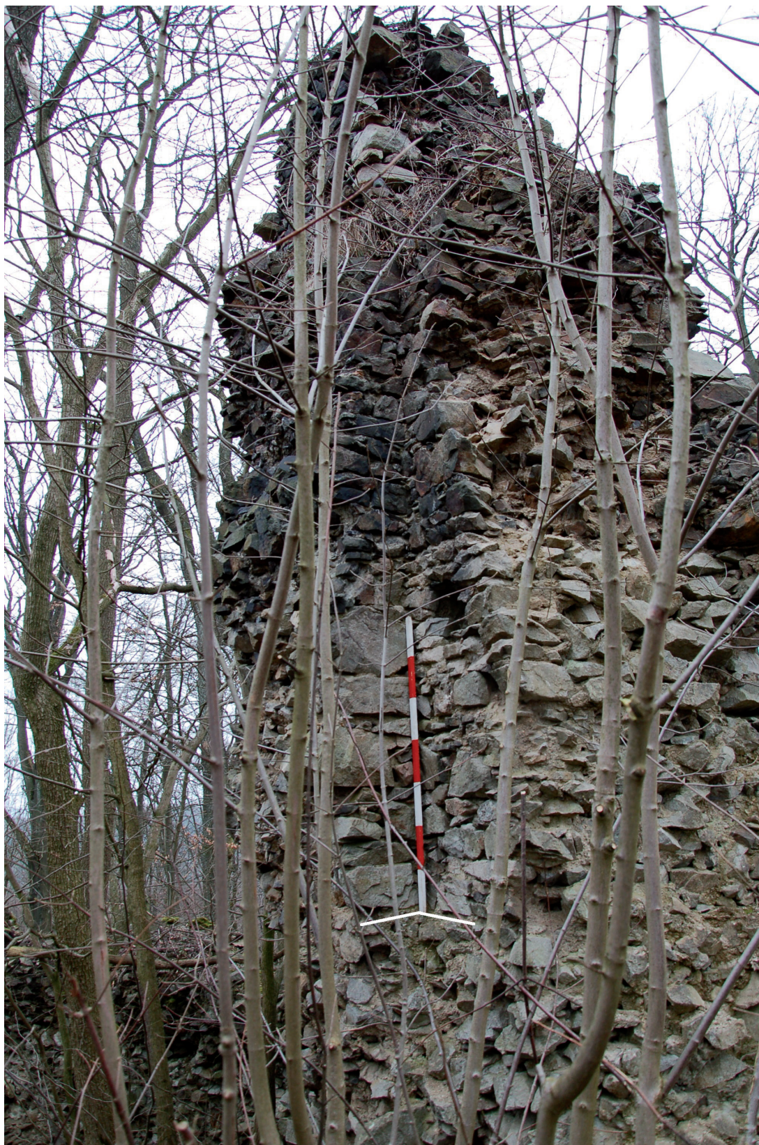
Obr. 12. Nový Herštejn. Jihozápadní kout interiéru v úrovni druhého patra čtverhranné věže v západním cípu obvodové hradby. Čarou je vyznačena viditelná úroveň odsazení zdi interiéru. Foto a úprava P. Kastl. – Abb. 12. Nový Herštejn. Südwestliche Ecke des Innenraums des viereckigen Turms im westlichen Fortsatz der Ringmauer auf der Höhe des zweiten Stocks. Die Linie markiert die sichtbare Ebene des Absatzes der Innenmauer. Foto und Bearbeitung P. Kastl.
