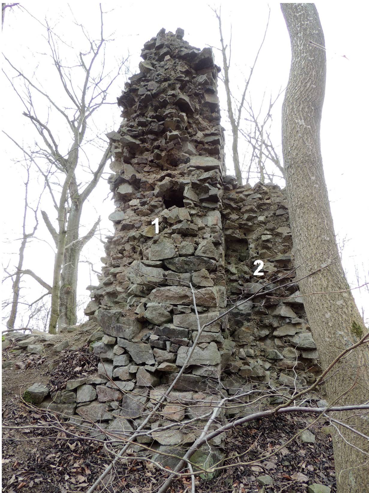
Obr. 16. Nový Herštejn. Relikt jihozápadního nároží jižní věže (1) s úsekem jihozápadní obvodové hradby v části provedené dozdivky předprší (2) této hradby. Foto a úprava P. Kastl. – Abb. 16. Nový Herštejn. Relikt der südwestlichen Ecke des südlichen Turms (1) mit einem Abschnitt der südwestlichen Ringmauer im Teil, in dem nachträglich die Brustwehr dieser Mauer (2) aufgemauert wurde. Foto und Bearbeitung P. Kastl.
