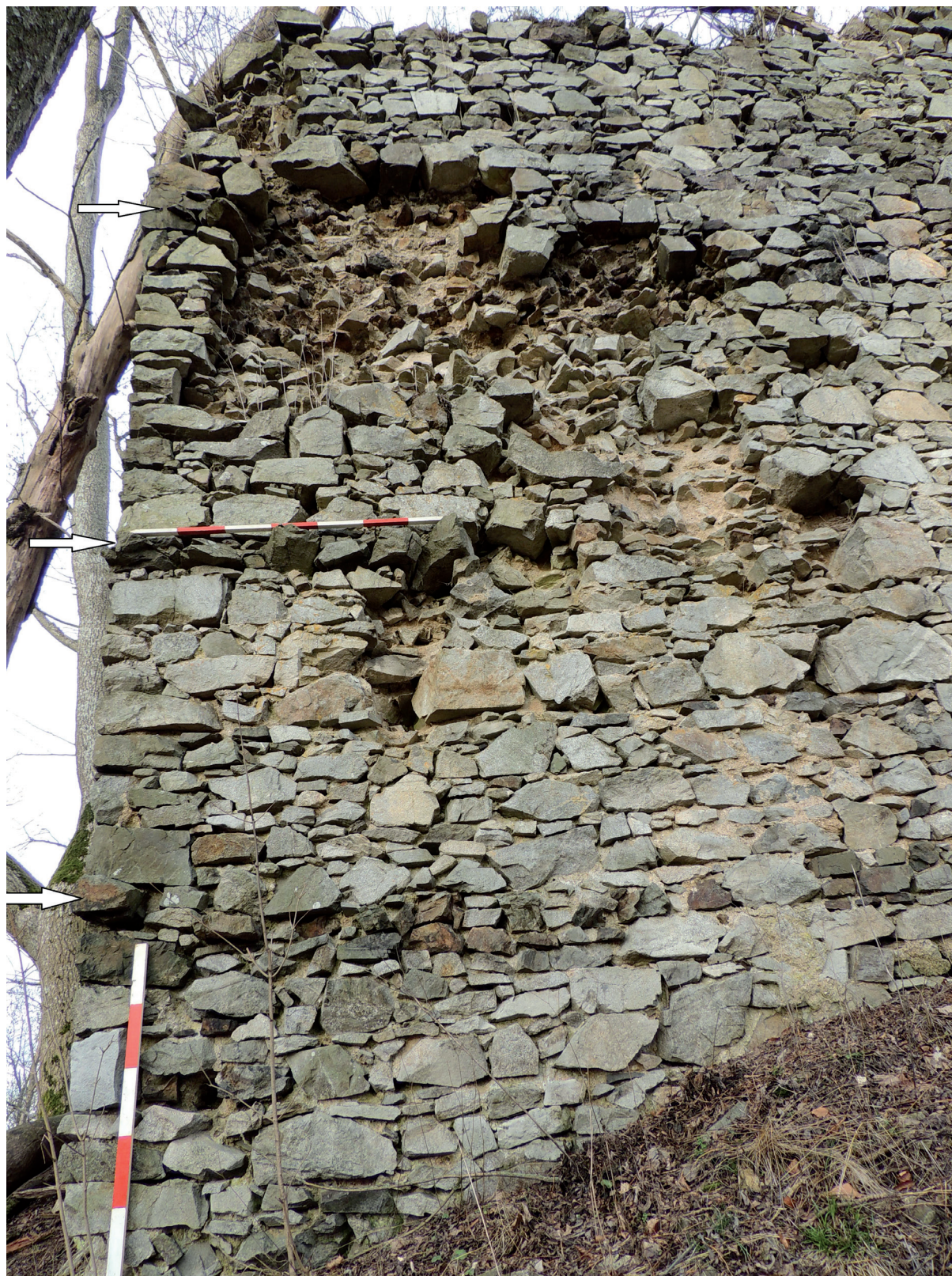
Obr. 3. Nový Herštejn. V pravidelných rozestupech vysazené šmarce (označeno šipkou) připravené pro provázání obvodové hradby jádra na jihozápadní nároží donjonu. Foto a úprava P. Kastl. – Abb. 3. Nový Herštejn. In regelmäßigen Abständen eingesetzte Schmarzen (mit Pfeilen markiert), die der Anbindung der Ringmauer der Kernburg an die südwestliche Ecke des Donjons dienen sollten. Foto und Bearbeitung P. Kastl
