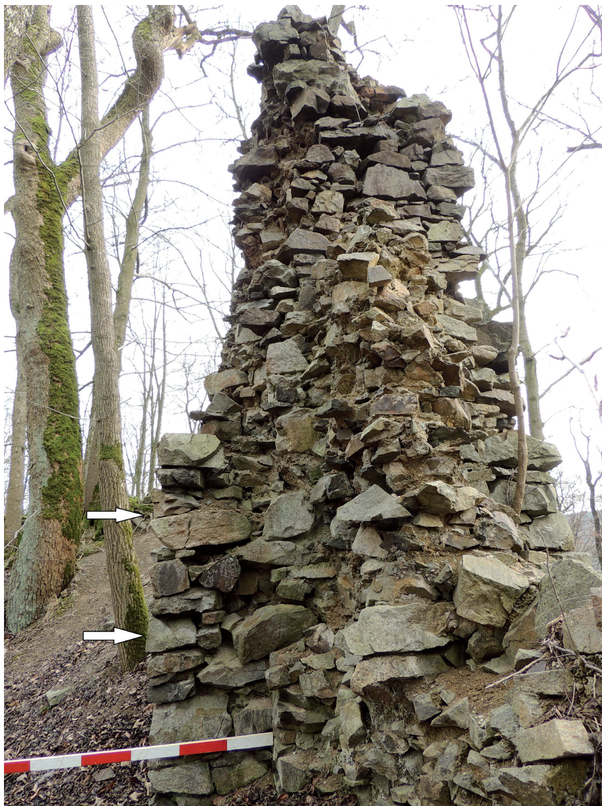
Obr. 15. Nový Herštejn. Relikt severozápadní zdi věžovitého objektu přistavěného k jižnímu zaoblenému nároží obvodové hradby. Šipkami je označena špaleta dveřního otvoru. Lať 1,4 m. Foto a úprava P. Kastl. – Abb. 15. Nový Herštejn. Relikt der nordwestlichen Mauer eines turmartigen, an die südliche, abgerundete Ecke der Ringmauer angebauten Objekts. Anbindungsstelle an die südwestliche Ringmauer. Mit den Pfeilen ist die Laibung einer Türöffnung markiert. Foto und Bearbeitung P. Kastl.
