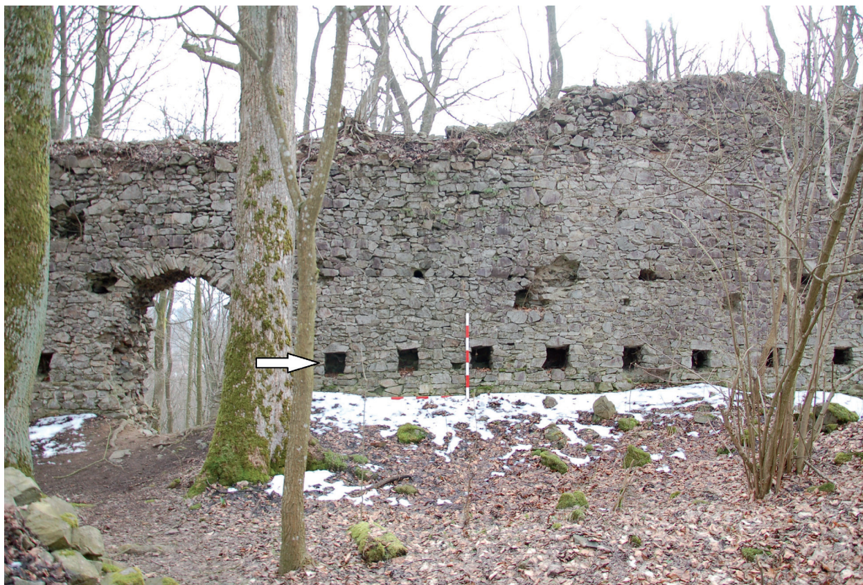
Obr. 6. Nový Herštejn. Primární otvory (označené šipkou) pro stropní trámy hospodářské budovy v jihozápadní části obvodové hradby. Latě 1,4 m. Foto a úprava P. Kastl. – Abb. 6. Nový Herštejn. Primäre Öffnungen (mit Pfeil markiert) für die Deckenbalken des Wirtschaftsgebäudes im südwestlichen Teil der Ringmauer. Latte 1,4 m. Foto und Bearbeitung P. Kastl.
