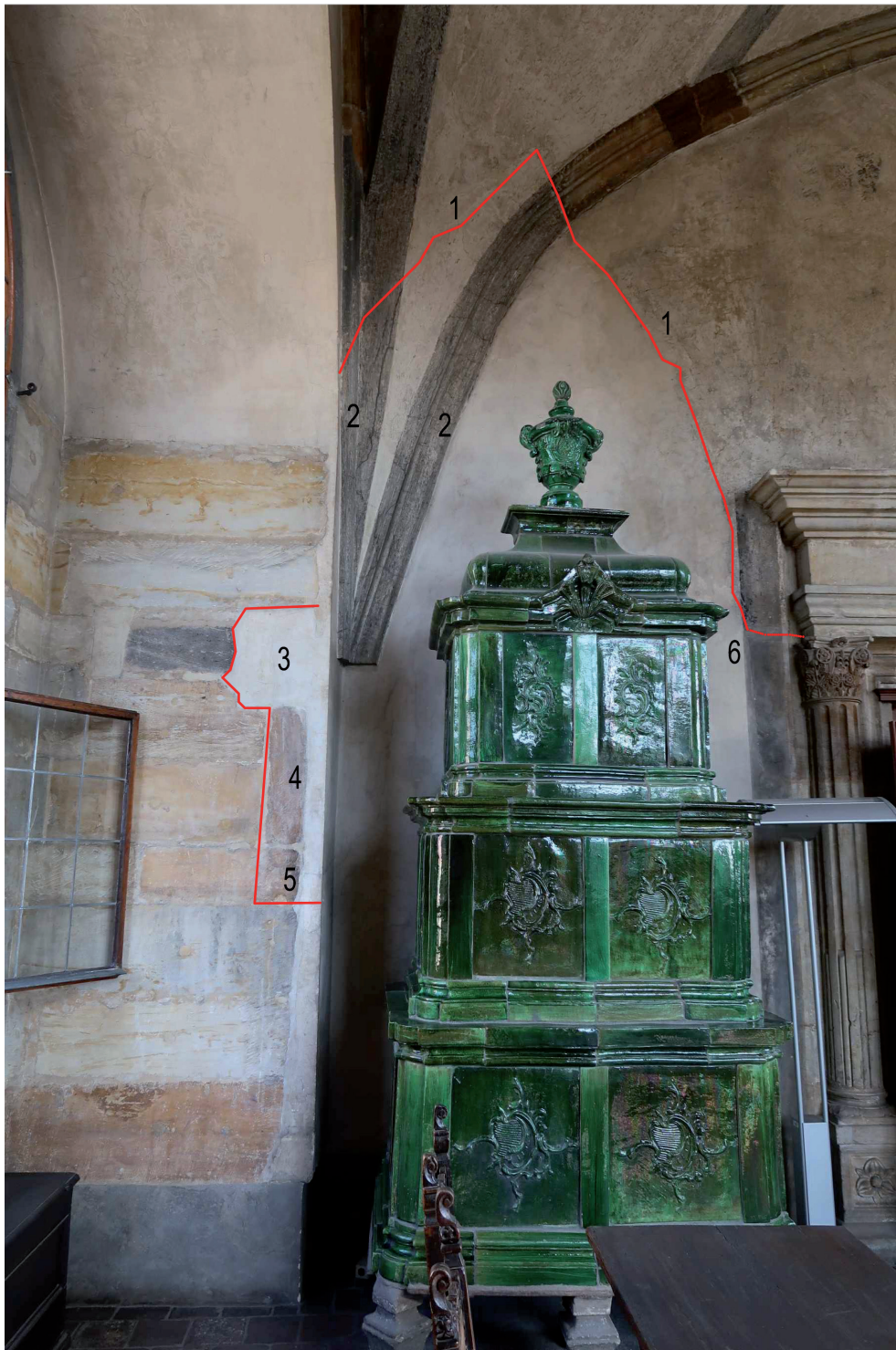
Obr. 11. Praha hrad. Otisk krbu na zdi ve čtvrtém podlaží v sále místodržících. 1 – rozhraní opravované omítkové plochy, 2 – klenební žebra doplněna ve štuku a malbě, 3 – předpokládaná pozice krbové římsy, 4 – svislý kvádr v okenním ostění, část druhotně odtesané konzoly krbu, 5 – kvádr v okenním ostění bez vazby část druhotně odtesané konzoly krbu, 6 – předpokládaná pozice krbové římsy – není jasné řešení detailu u bohatě zdobeného portálu. Foto a kresba M. Biedermanová. – Abb. 11. Prager Burg. Abdruck eines Kamins in der Wand des vierten Stockwerks im Statthaltersaal. 1 – Umriss der reparierten Putzfläche, 2 – in Stuck und Malerei ergänzte Gewölberippen, 3 – mutmaßliche Position des Kaminsimses, 4 – senkrechter Quader in der Fensterwandung, Teil einer nachträglich entfernten Kaminkonsole, 5 – Quader in der Fensterwandung ohne Anbindung, Teil einer nachträglich entfernten Kaminkonsole, 6 – mutmaßliche Position des Kaminsimses – wie dieser konkret mit dem reich verzierten Portal verbunden war, ist unklar. Foto und Zeichnung M. Biedermanová.
