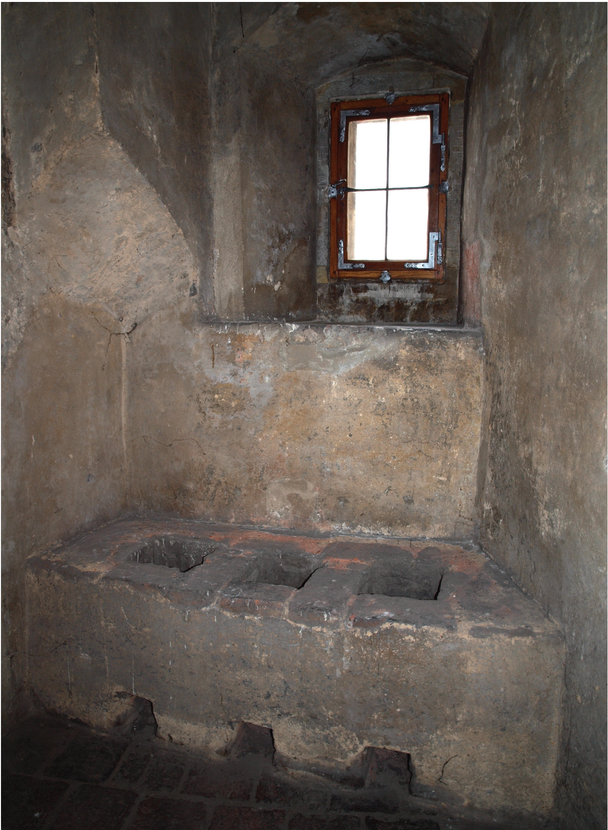
Obr. 12. Praha hrad. Topeniště v okenní špaletě v obslužném prostoru v 5. podlaží. Foto M. Cejpová. – Abb. 12. Prager Burg. Feuerstätte im Fensterstock im Befeuerungsraum des 5. Stockwerks. Foto M. Cejpová.
