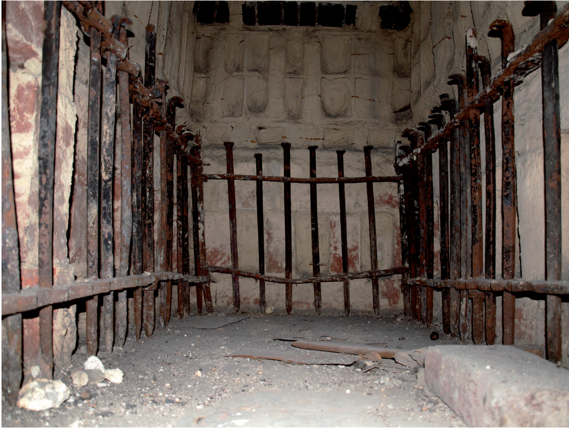
Obr. 7. Praha hrad. 3. podlaží, železný kovaný koš ve spodní části kachlových kamen chránící kachle před poškozením při přikládání. Foto M. Cejpová. – Abb. 7. Prager Burg. 3. Stockwerk, geschmiedeter Eisenkorb im Unterteil des Kachelofens zum Schutz der Kacheln vor Beschädigung bei der Befeurung. Foto M. Cejpová.
