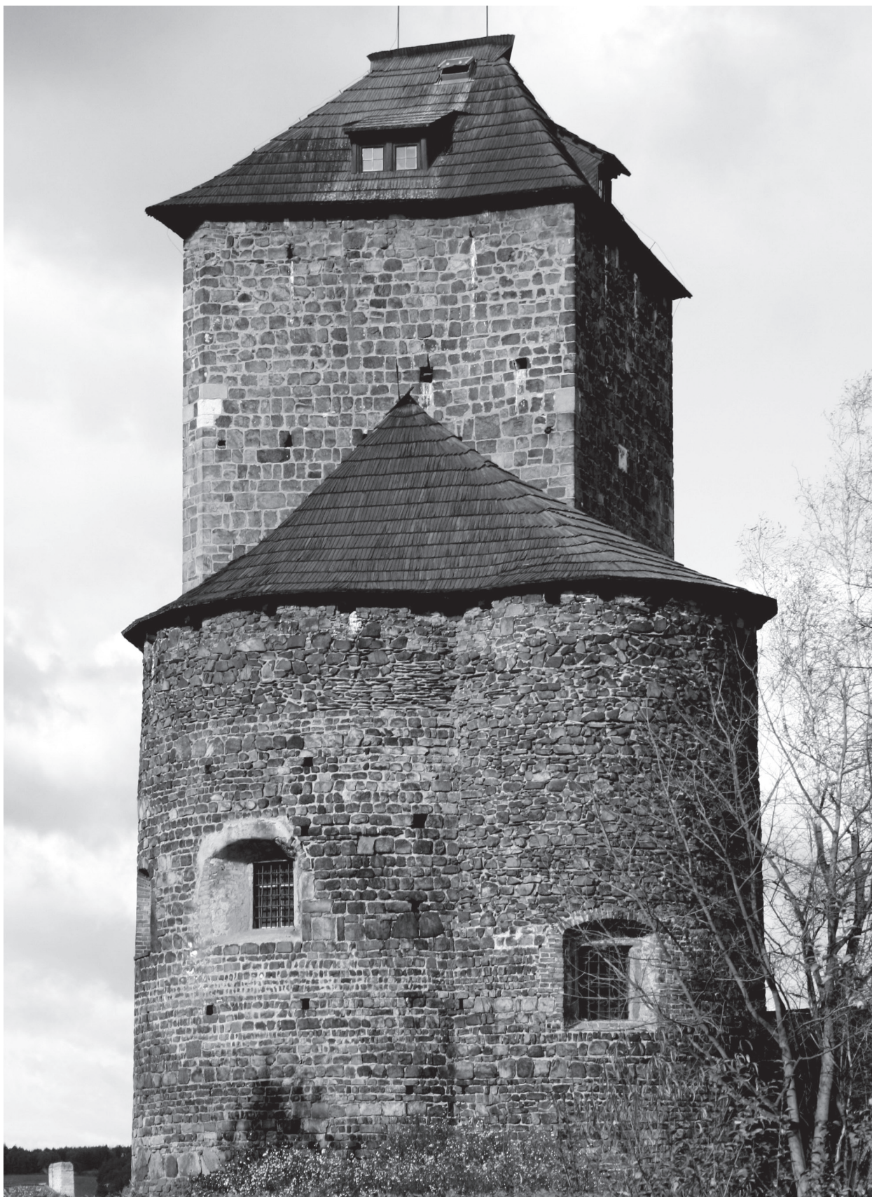
Obr. 2. Týnec nad Sázavou. Pohled na rotundu s hradní věží od jihu. Foto autor. – Abb. 2. Týnec nad Sázavou. Blick auf die Rotunde mit Burgturm aus südlicher Richtung. Foto Autor.
