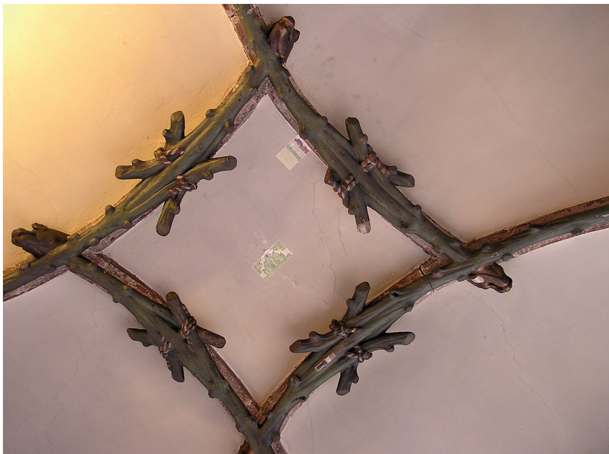
Obr. 4. Štrasburk, dům č. 10-11 na Place de la Cathédrale. Detail pozdně gotické klenby v přízemí s žebry ve formě větví svázaných provazem. Foto autor. – Abb. 4. Straßburg, Haus Nr. 10-11 auf dem Place de la Cathédrale. Detail eines spätgotischen Gewölbes im Erdgeschoss mit Rippen in Form geschnürter Zweige. Foto Autor.
