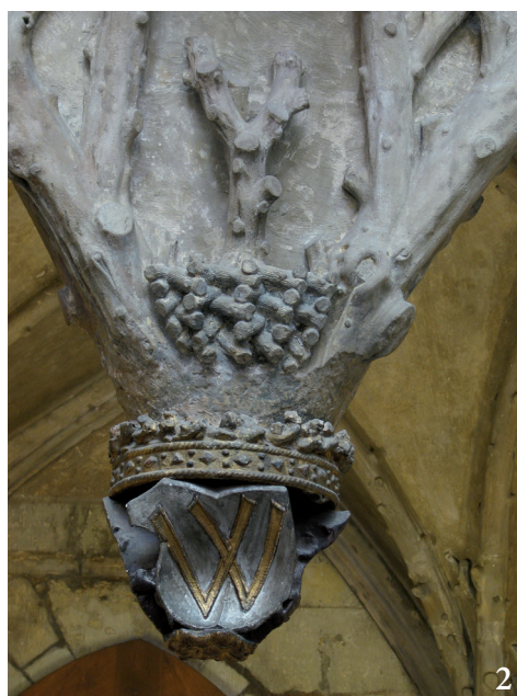
Obr. 2. Katedrála sv. Víta, královská oratoř. Detail zakončení visutého svorníku s třemi kolčími štítky (na snímku jeden z nich s iniciálou W) pod královskou korunou, na níž byl užit motiv propletených větvíček. Foto autor. – Abb. 2. Veitsdom, Königliches Oratorium. Detail des Endes des hängenden Schlusssteins mit drei Schilder (auf der Abbildung eines mit dem Initial W) unter der Königskrone, in der das Motiv verschlungener Zweige genutzt wurde. Foto Autor.
