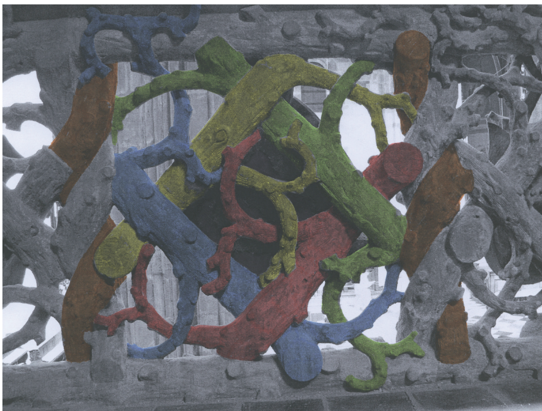
Obr. 12. Katedrála sv. Víta, královská oratoř. a) detail typického pole zábradlí (vytesáno z jednoho kusu pískovce), b) systém propletení větví. Foto autor. – Abb. 12. Veitsdom, Königliches Oratorium. a) Detail eines typischen Geländerfelds (aus einem Stück Sandstein gehauen), b) Websystem der Zweige. Foto Autor.
