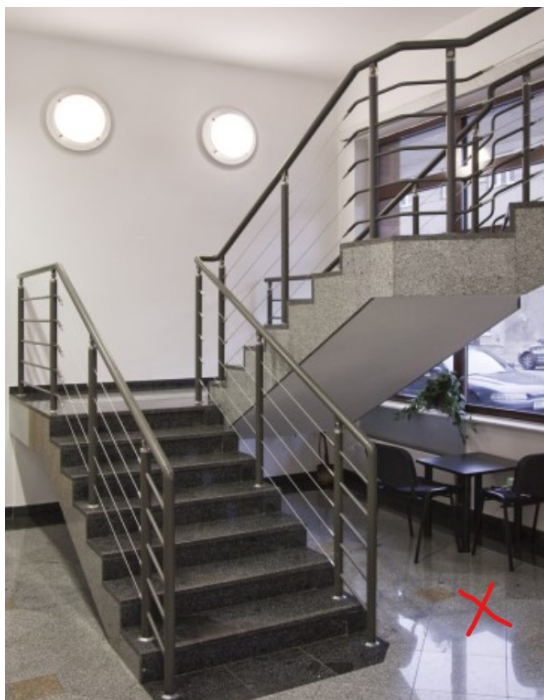
Obrázek 4 - špatné řešení schodiště [7]
