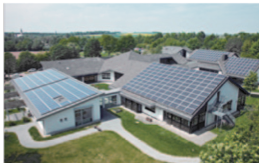
Die PV-Anlagen auf der Theodor-Heuss-Schule
