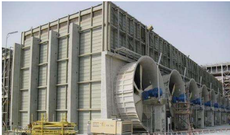
Obrázek 24: Chladicí věž s vertikálními ventilátory
