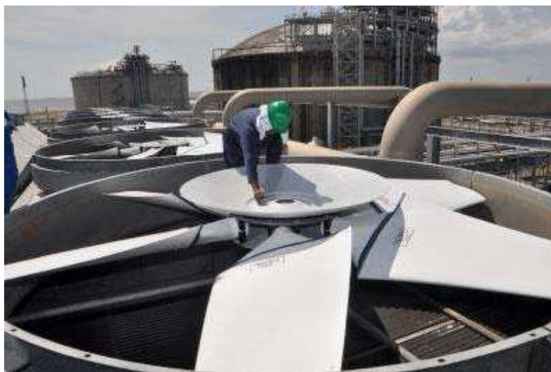
Obrázek 27: Ventilátor chladicí věže s mužem pro představu velikosti
