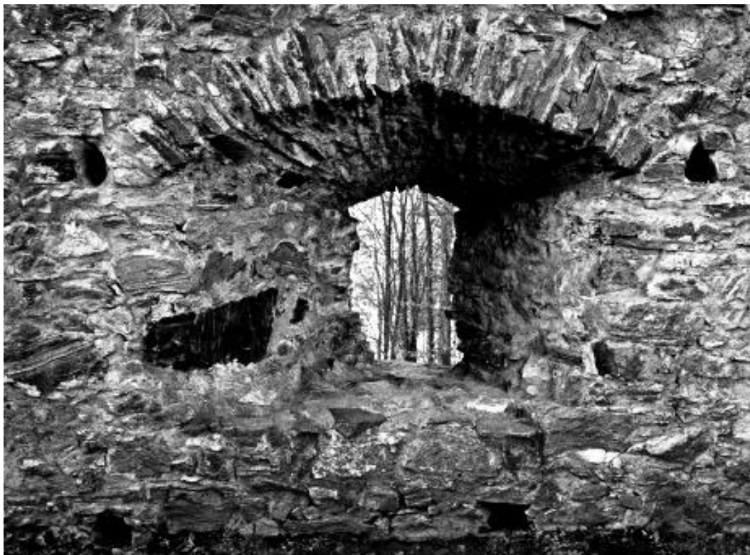
Obr. 3: Střílna v ohradní zdi předsunutě břitové věže Českého Šternberka. V rozích patrné trámové kapsy, možné pozůstatky dřevěné konstrukce pro zachycení zpětného rázu lafetované palné zbraně
