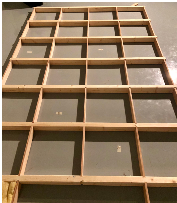
Obr. 6.1: Konstrukce před vložením vaty
