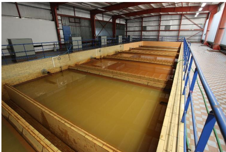
Obrázek 4 odželezňování vody v technologické praxi na pískových filtrech Zdroj: Autor: Che(Please credit as "Petr Novák, Wikipedia" in case you use this outside WMF projects.) – Che, CC BY-SA 3.0, https://commons.wikimedia.org/w/index.php?curid=9098369
