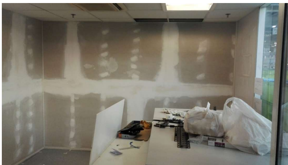
Obr. 3.4.4 Finalizace přestavby pro montáž televizorů.
