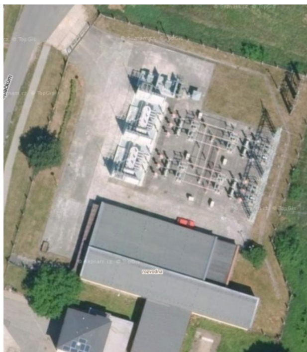
Obr. 15: Rozvodna TR 110/22 kV Mladé v Českých Budějovicích [14]
