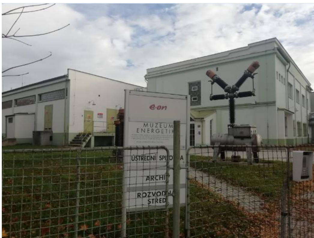
Obr. 9: Objekt spínací stanice Střed
