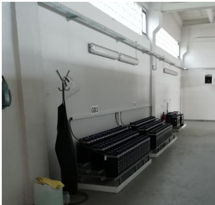
Obr. 13: Baterie pro vlastní spotřebu
