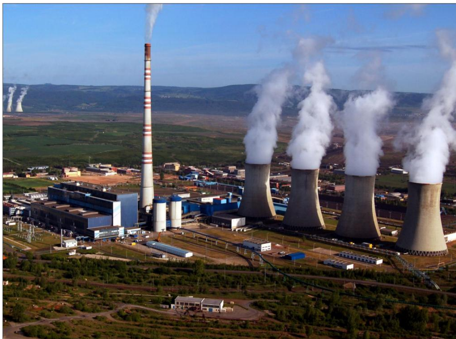
Obr.4 – Elektrárna Tušimice II. před obnovou [7]
