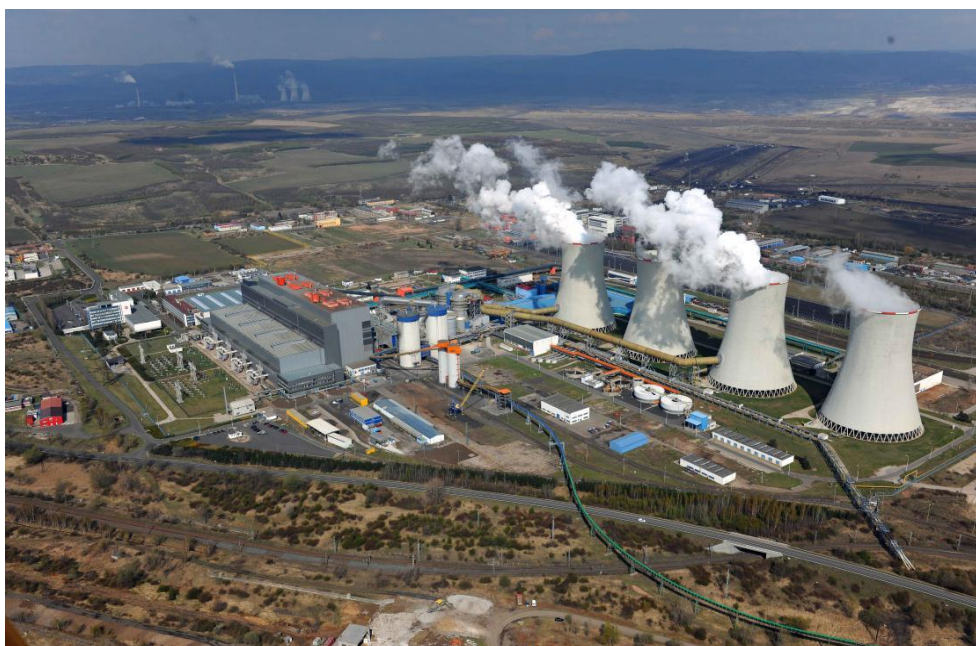
Obr.5 – Elektrárna Tušimice II. po obnově [7]
