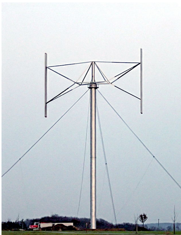
Obrázek 2 - Darrierova turbína s rotorem ve tvaru H [9]
