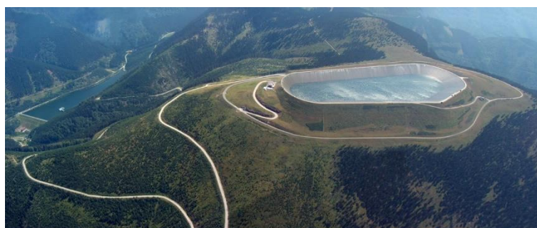
Obrázek 25: Přečerpávací vodní elektrárna Dlouhé Stráně
