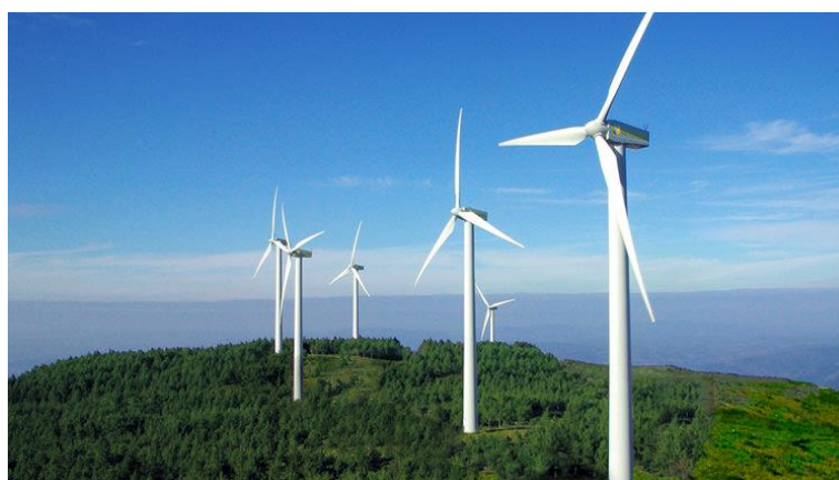
Obrázek 9: Horizontální turbíny s natáčením pomocí servomotoru
