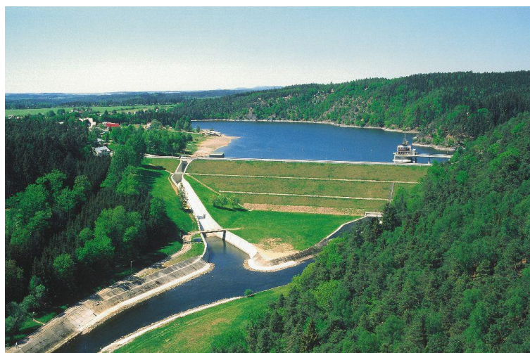
Obrázek 24: Akumulační elektrárna Hracholusky
