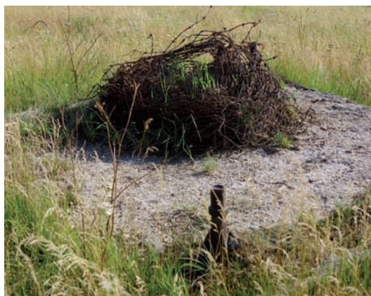
7) Betonový základ pro věž hlídky protiletadlové obrany na vrchu Kňourek (foto L. Funk). Das Betonfundament für den Wachturm des Luftschutzes auf dem Hügel Georgenberg (Foto: L. Funk).
