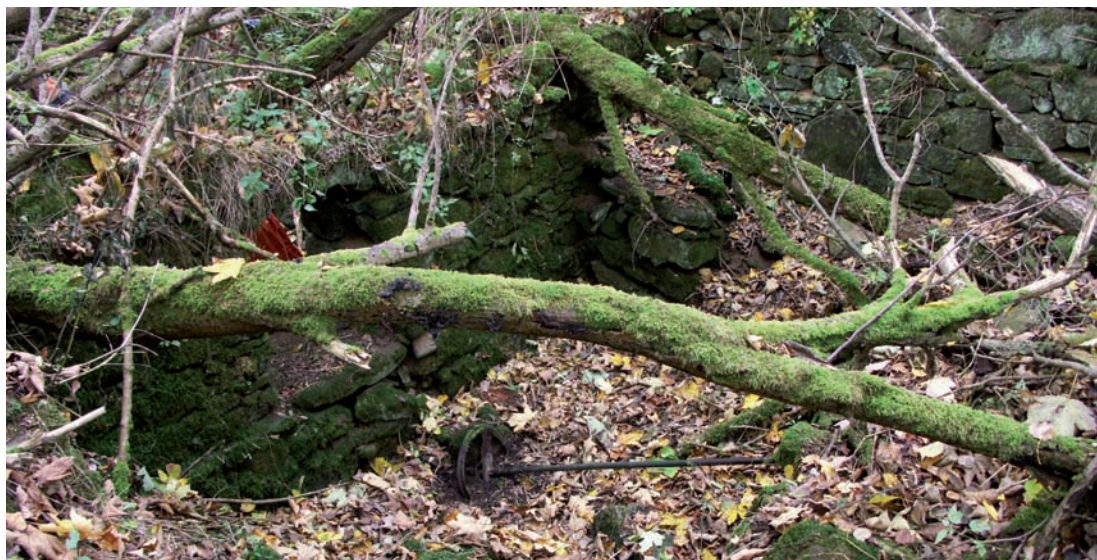
3) Mášův mlýn (okres Tachov). Pohled do mlýnice od jihozápadu. Kamenná zeď je návodní zdi, za níž se otáčelo vodní kolo (zde se nalézala lednice), přičemž otvorem procházela hřídel dovnitř místnosti a roztáčela pomocí palečného kola následně celý mlecí mechanismus. V Mášově mlýně zůstal dochován archaiský mlecí mechanismus. V mlýnici, kde pracoval mlecí stroj, se na současném povrchu terénu dochovala litinová tyč o průměru 3,5 až 4 cm, osazená kovovou řemenicí (na fotografii přibližně uprostřed). Patrně součást nějakého doplňkového zařízení využívajícího vodní energii. Snad součást stroje na výrobu perletových knoflíků (foto: J. Anderle 2007). Máša-Mühle (Kreis Tachau). Blick in das Mühlhaus von Südwest. Die Steinmauer ist eine Zuleitungsmauer, hinter der sich das Mühlrad drehte (hier befand sich auch die Kühlkammer), wobei die Welle durch die Öffnung in den Raum ragte und anschließend mittels des Daumenrades den ganzen Mahlmechanismus in Gang setzte. In der Máša-Mühle blieb ein archaischer Mahlmechanismus erhalten. Im Mühlhaus, in der die Mahlmaschine arbeitete, blieb auf dem gegenwärtigen Gelände eine mit einer Metallriemenscheibe besetzte Gusseisenstange mit einem Durchmesser von 3,5 bis 4 cm erhalten (auf dem Foto ca. in der Mitte). Diese war wahrscheinlich ein Bestandteil einer zusätzlichen, Wasserkraft nutzenden Anlage. Vielleicht Bestandteil einer Maschine für die Fertigung von Perlmuttern (Foto: J. Anderle 2007).
