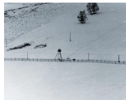
8) „Železná opona“ na německém leteckém snímku z roku 1985 (SOKA Tachov). Der Eisener Vorhang auf einer deutschen Luftaufnahme vom 1958 (SOKA Tachov).
