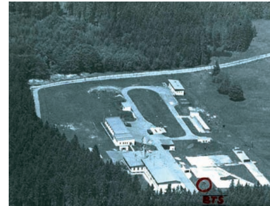
4) Rota pohraniční stráže Stoupa nedaleko Staré Knížecí Hutě na německém leteckém snímku z roku 1985 (SOKA Tachov). Eine Kompanie des Grenzschutzes Altpocher bei Alt Fürstenhütte auf einer westdeutschen Luftaufnahme aus dem Jahre 1985 (SOKA Tachov).
