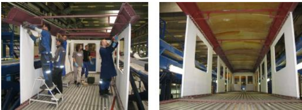
Obr. 25 Fotografie z montáže bočnicových a mezidvěrných modulů a vaznice a pohled do hotové skříně
