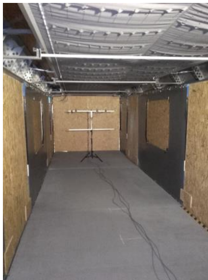
Obr. 104 Fotografie stojanu s upevněnou trojicí sond
