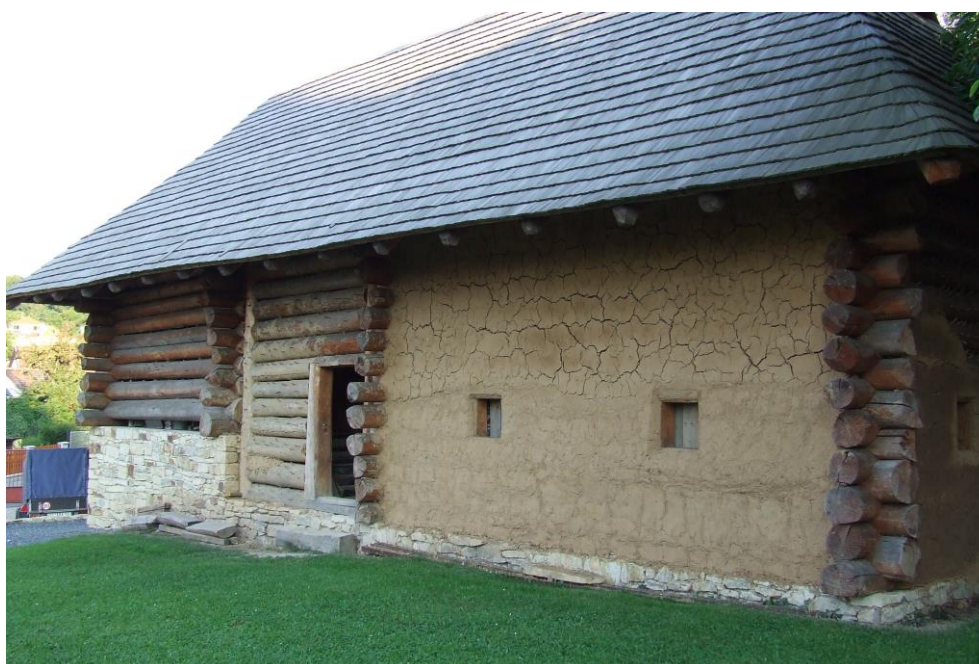
Obr. 13. Archeopark Praha-Liboc. Trojdílný roubený dům po omazání jizby.
