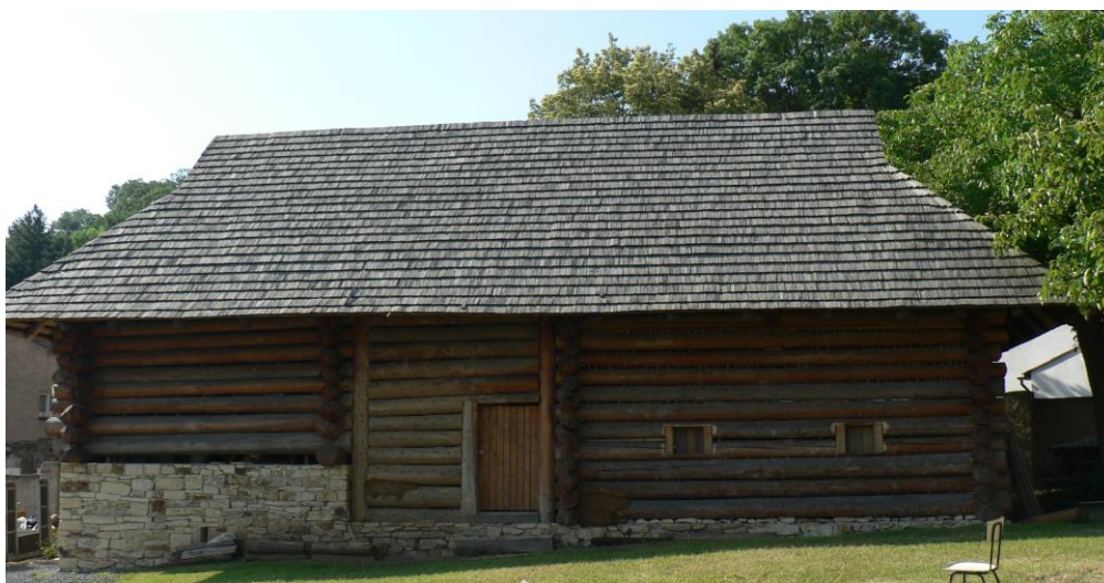
Obr. 12. Archeopark Praha-Liboc. Trojdílný roubený dům před omazáním. V přední části dýmná jizba, dále střední síň a vzadu patrová komora se spodní částečně zapuštěnou vyzděnou částí.
