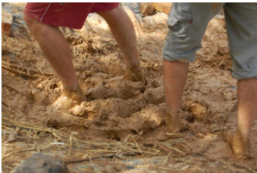
Obr. 15. Archeopark Praha-Liboc. Příprava mazanice šlapáním sprašové hlíny s příměsí slámy a sena.
