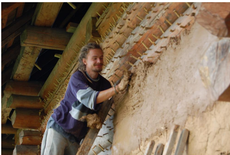
Obr. 16. Archeopark Praha-Liboc. Omazávání vrchní části roubené stěny (první vrstva omazu).
