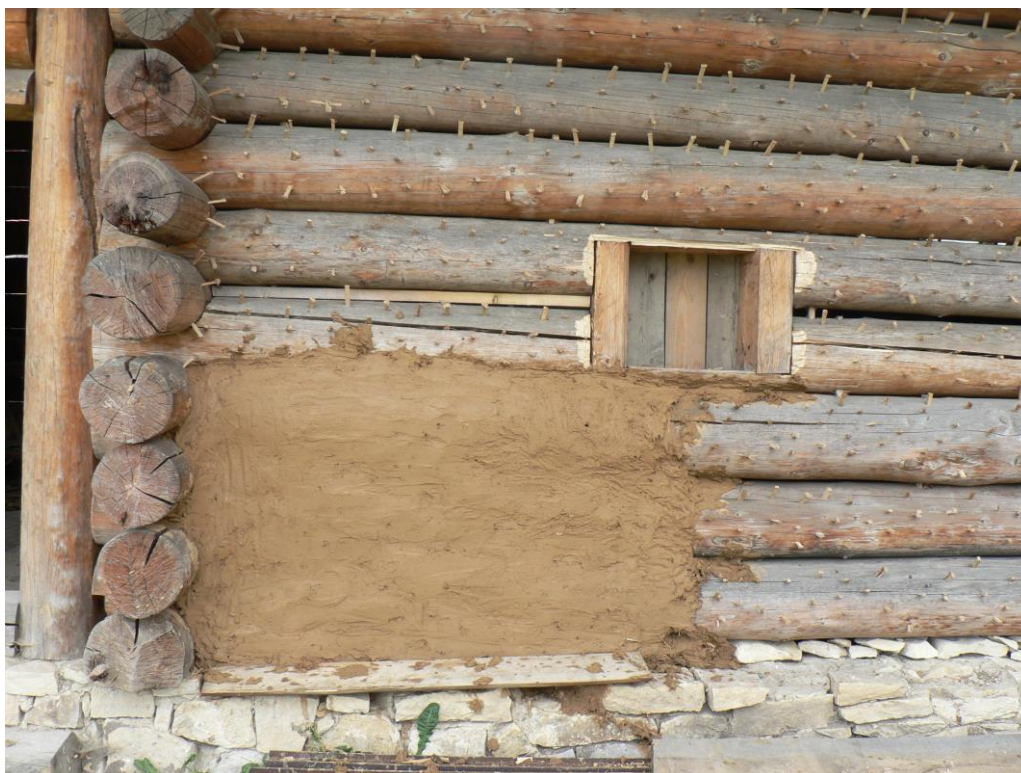
Obr. 14. Archeopark Praha-Liboc. Omazávání roubené konstrukce opatřené dřevěnými kolíčky.
