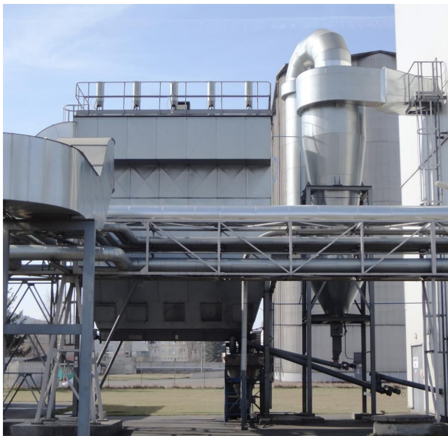
Obrázek 3: Textilní filtr a cyklonový odlučovač za kotlem K4 (foto autor)
