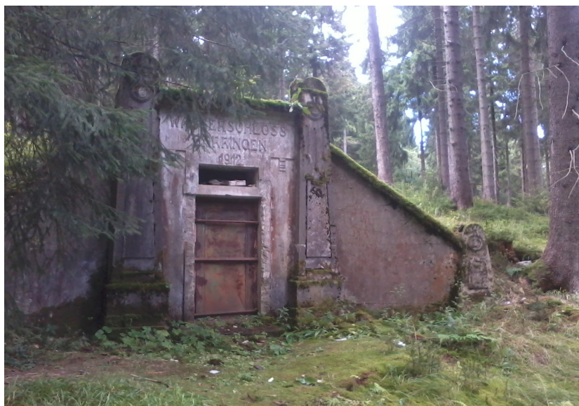
Obr. č. 10 Horní nádrž vodojemu (zdroj: Kváča Aleš)
