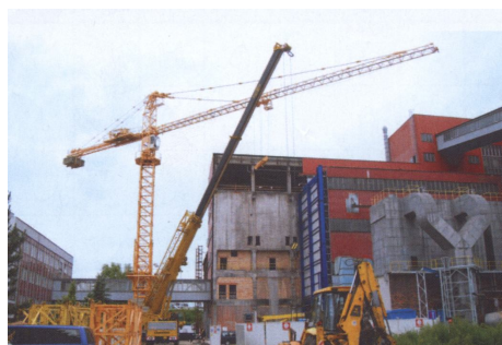
Bild 1 – Arbeit an dem Aufbau des neuen Blockes [1]
