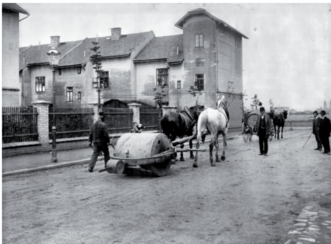
Obr. 27: Válcování silnice na Karlově po dokončení jeho výstavby v roce 1913. (Zdroj: NOV-ZČM)
