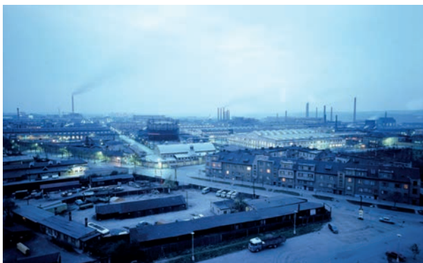
Obr. 15: Pohled na Škodovku od Borské ulice, 70. léta 20. století. (Zdroj: Mazný–Šrámek 2009)
