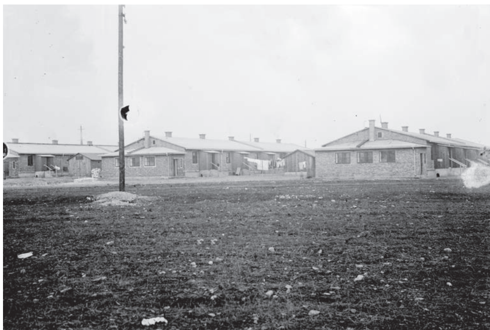
Obr. 19: Nouzové baráky v Plzni na Borech. Dřevěné barákové kolonie tvořily nejpodstatnější část nouzového ubytování. Původně se jednalo o ubikace dělníků-vojáků ve Škodových závodech za války, podnik je po roce 1919 prodal nebo daroval obci. V roce 1921 bydlelo ve 14 barácích na Borech 247 rodin – více než 1000 osob – ve 233 bytech. (Foto: K. Koubek, zdroj: NMP a Kříž 1925: 280–284)
