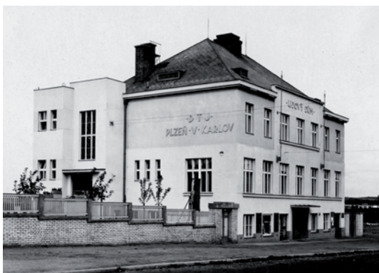
Obr. 39–45: Stavba Lidového domu a cvičiště Dělnické tělocvičné jednoty. (Zdroj: osobní archiv Ladislava Fialy)
