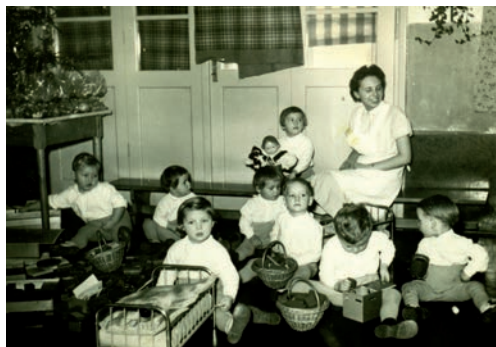
Obr. 60: Karlovská mateřská škola. (Zdroj: osobní archiv Jarky Kripnerové)
