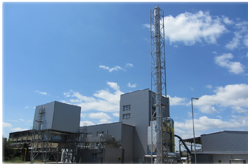
Figure 3 – View of area of Košická energetická spoločnosť a.s.
